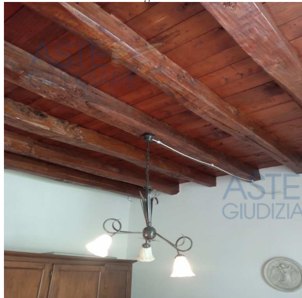
Foto n. 30 – Soffitto in travi legno
