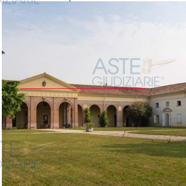
Foto n. 2 – Esterno del porticato
