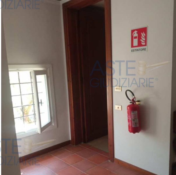
Foto n. 8 – Ballatoio interno con adiacente porta d'ingresso
