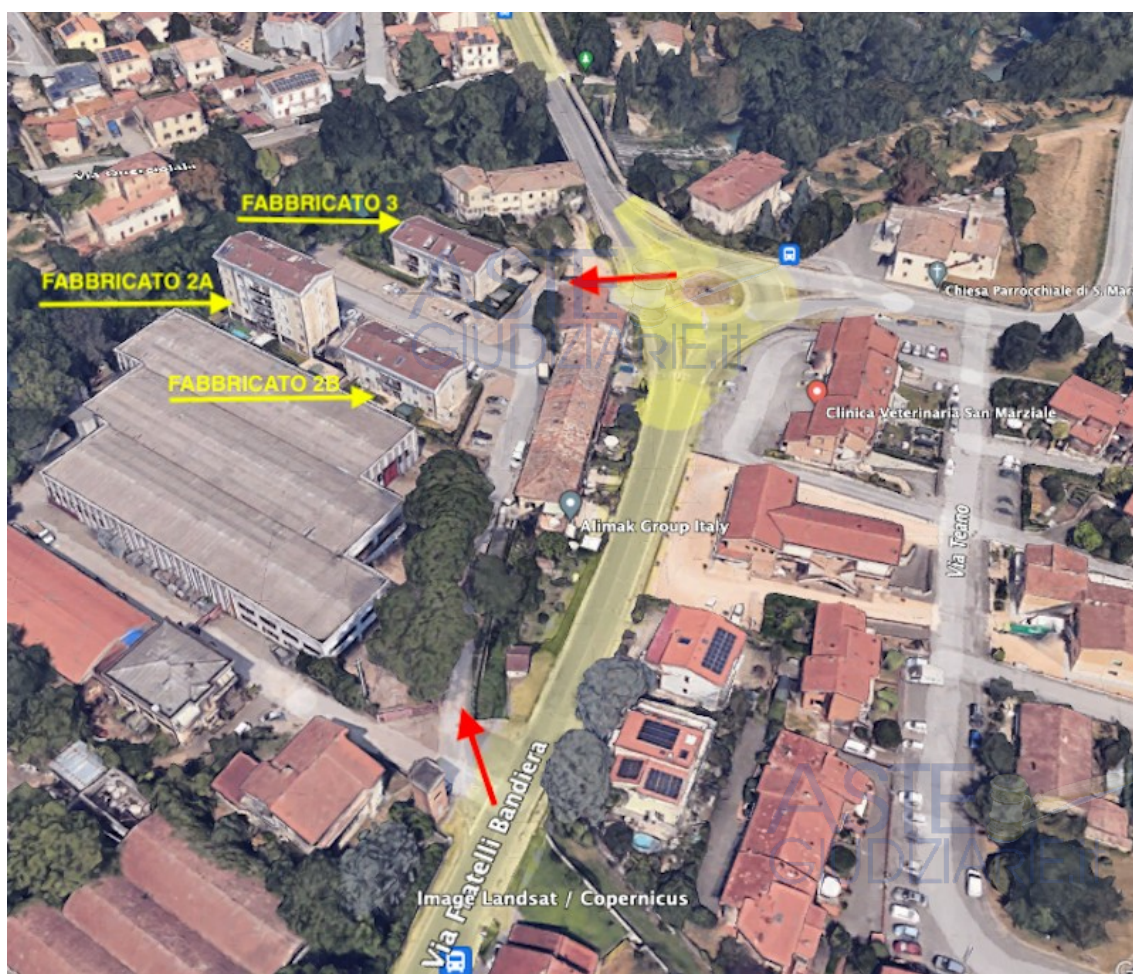
Foto n. 3 – Panoramica complesso residenziale
