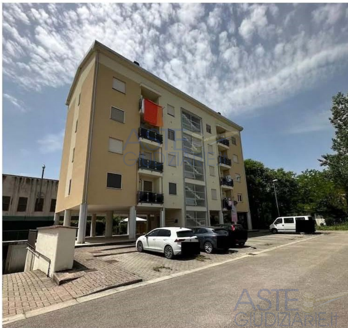
Foto n. 4 – Panoramica Fabbricato 2A
