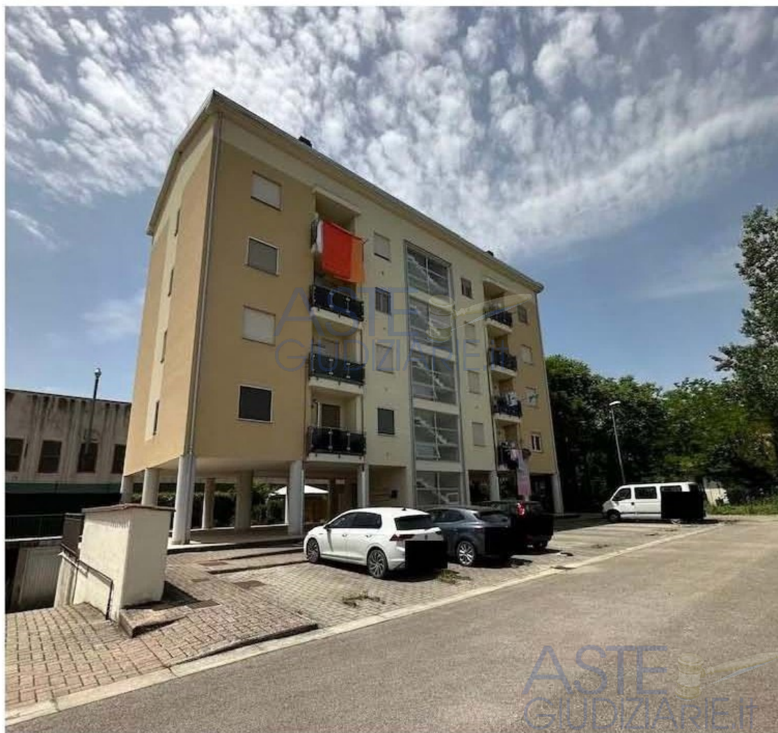
Foto n. 4 – Panoramica Fabbricato 2A
