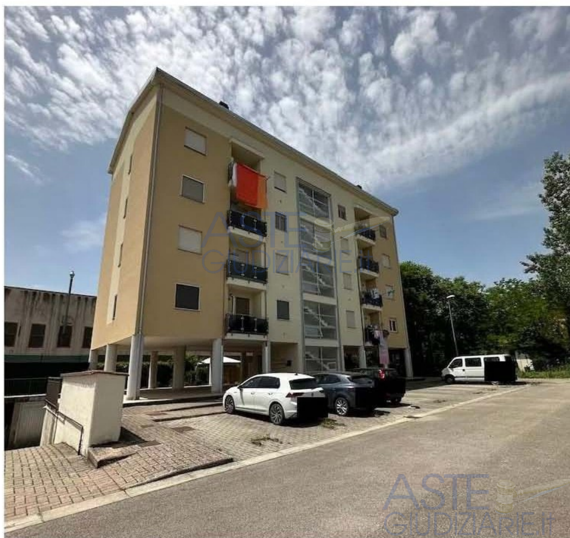
Foto n. 4 – Panoramica Fabbricato 2A
