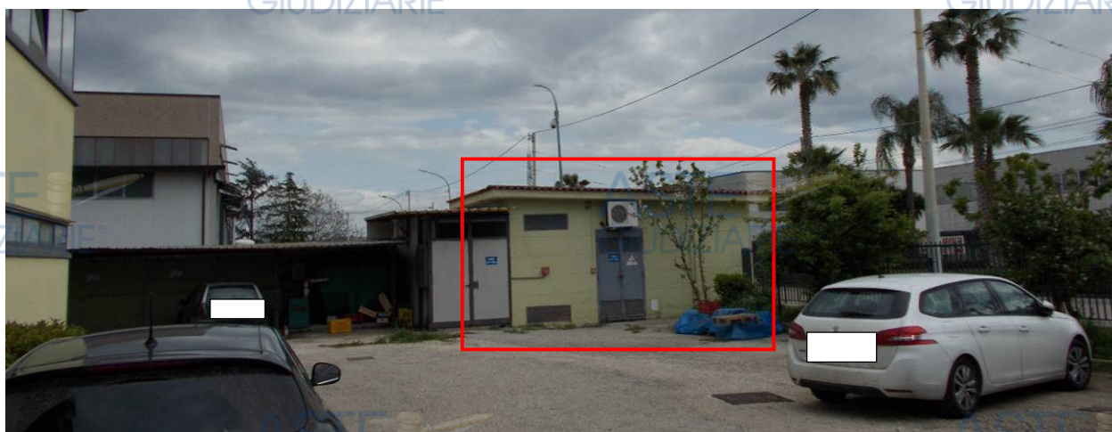
L'immobile sub 1 (C/2)
