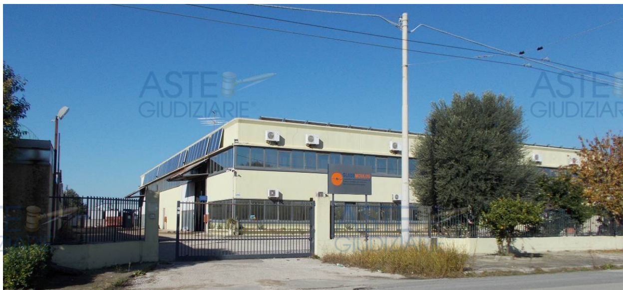
L'immobile sub 2 (D/7) visto dalla II traversa zona ASI Aversa Nord
