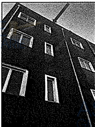
Figura 41. Prospetto nord della palazzina. Particolare chiusura finestre.
