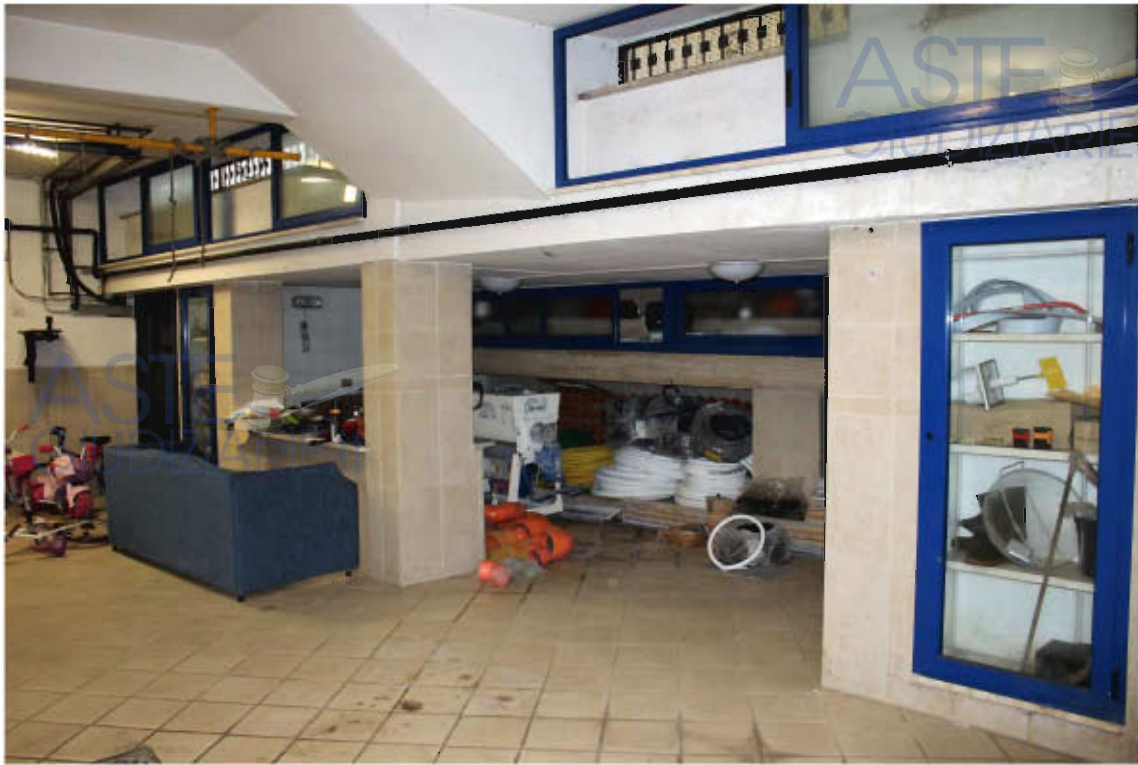
Parte bassa al di sotto della corsia di accesso al cortile interno
