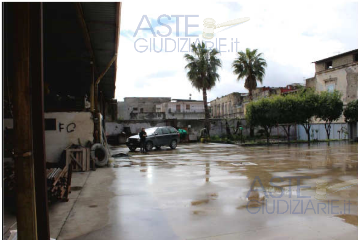
Altra vista del cortile guardando verso il confine sud
