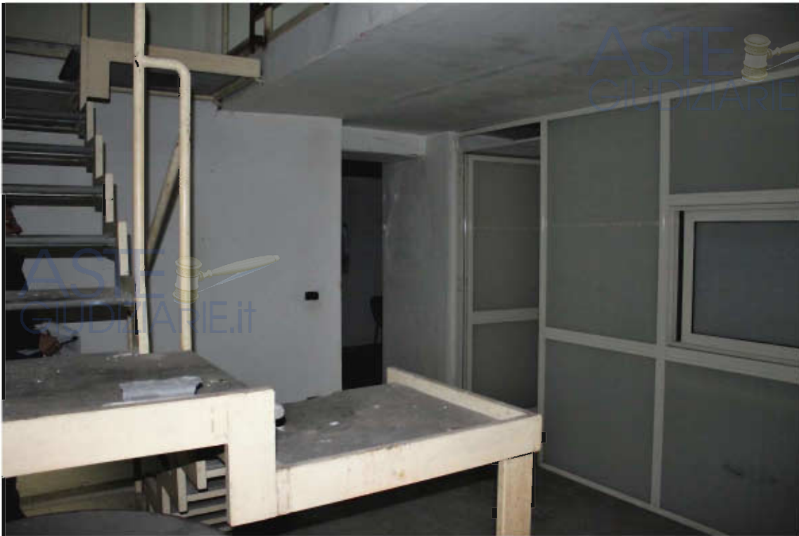
Piano interrato la scala
