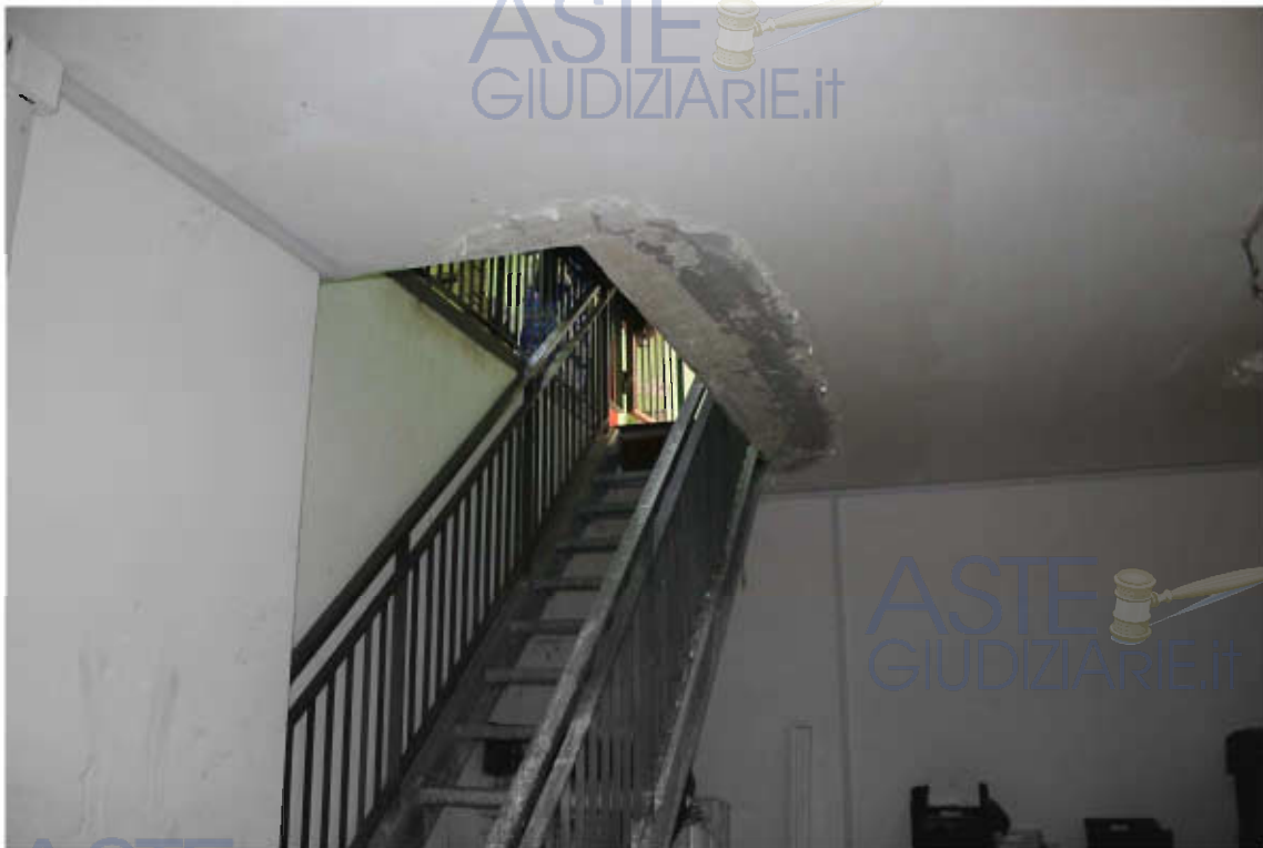
Vista dal locale interrato verso la scala
