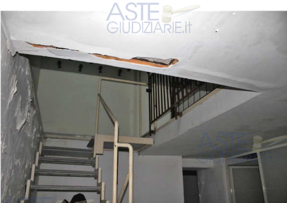
Piano interrato la scala
