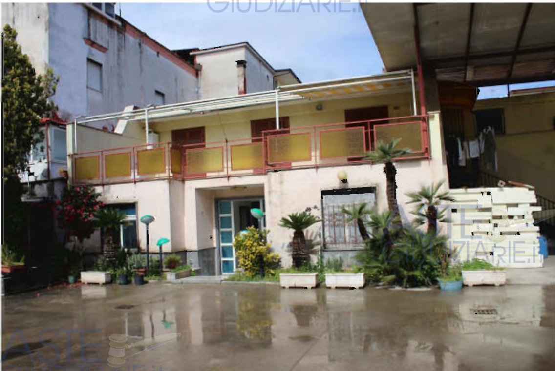
ABITAZIONE AL PIANO TERRA E PIANO PRIMO
