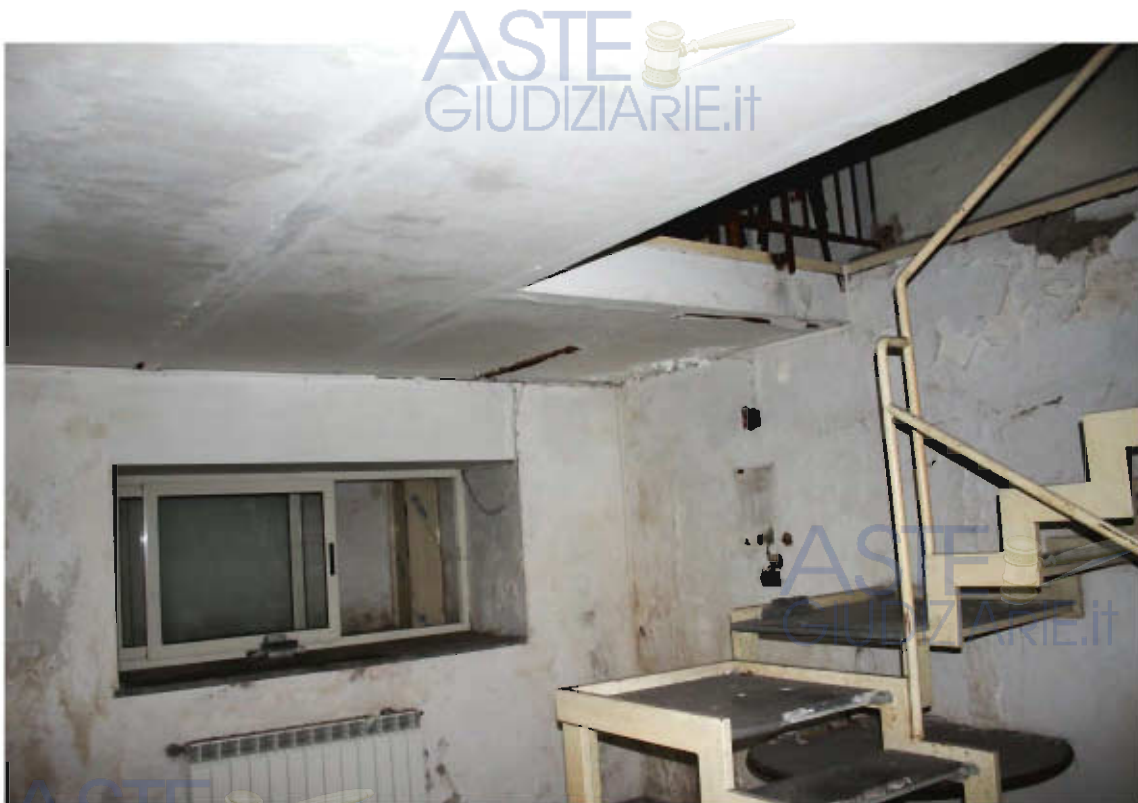
Piano interrato la scala
