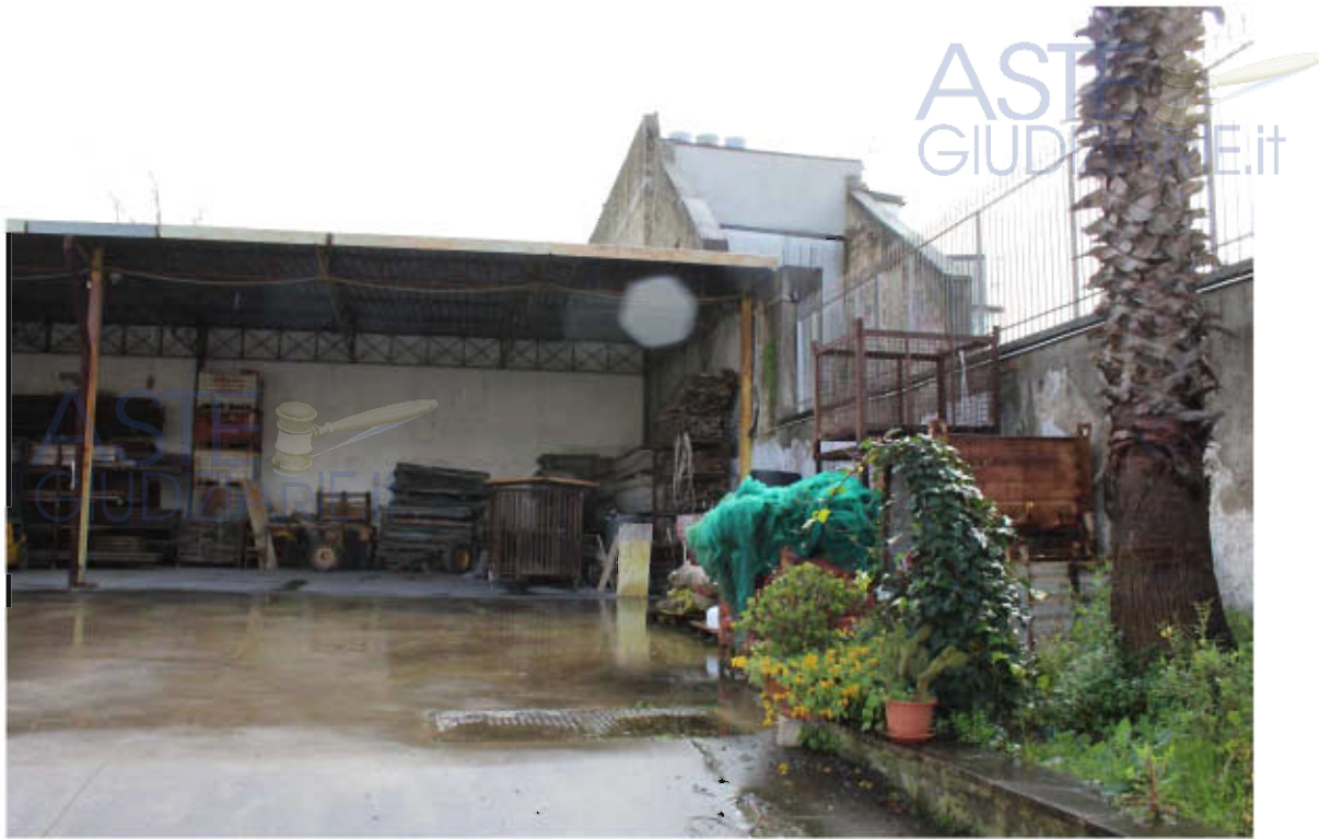
Altra vista della tettoia e del confine sud
