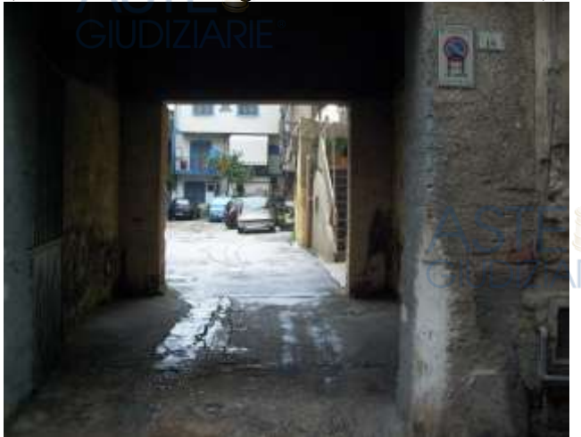
(foto 4: Vista particolare androne e corte)
