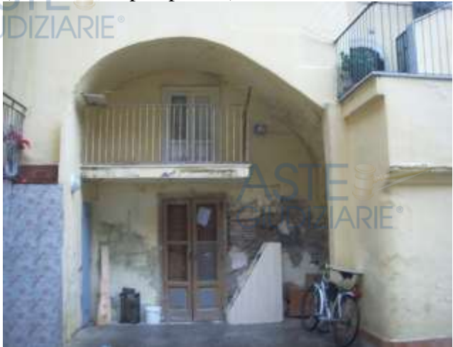
(foto 3: Accesso monolocale interno corte)
