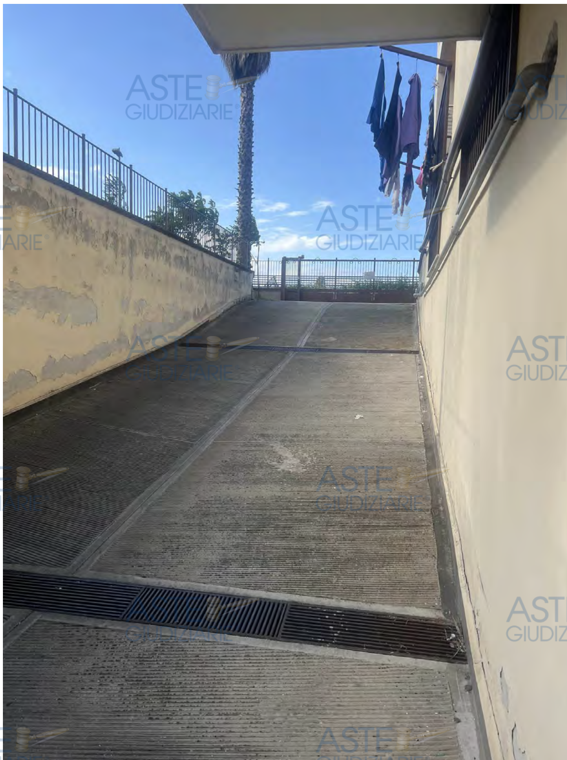
Foto rampa di accesso
