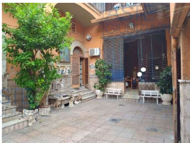
Porticato visto dall'area di corte scoperta
