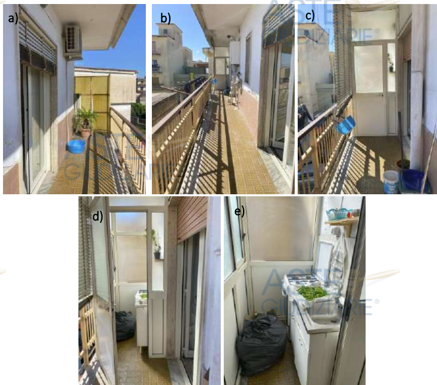
Figura 6: a), b), c) balcone 1; d), e) dettaglio interno veranda
