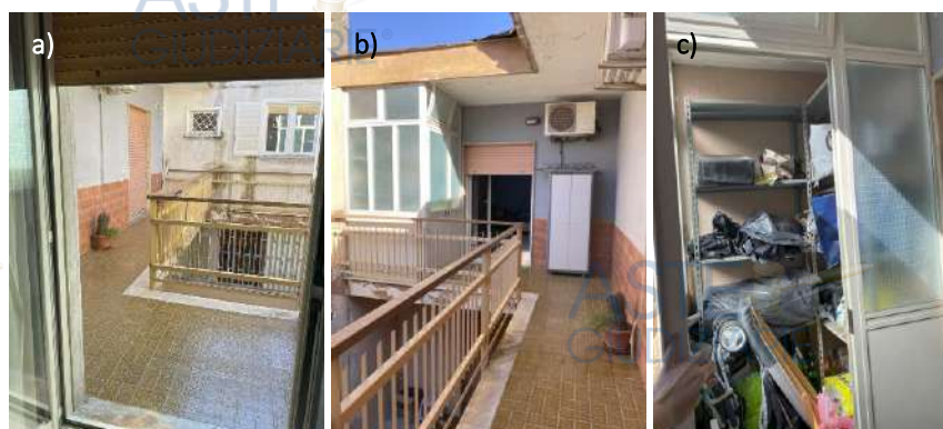
Figura 7: a), b) balcone 2; c) interno veranda
