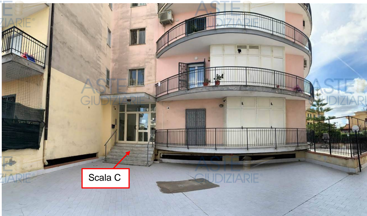
Foto 04 – L'ingresso alla scala C
