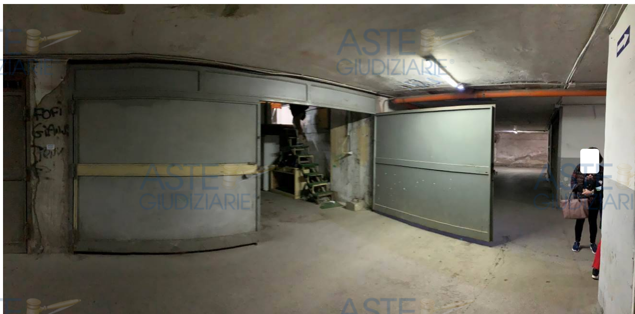
Foto 20 - Zona comune di manovra ed accesso al sub 95
