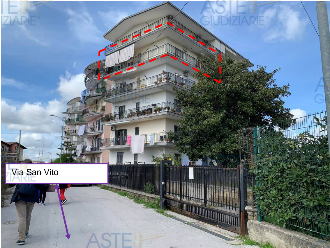
Foto 02 – Il fabbricato dalla via San Vito
