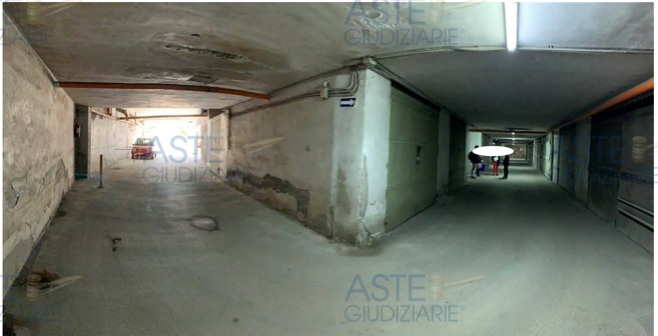
Foto 21 – Zona comune di manovra al piano seminterrato
