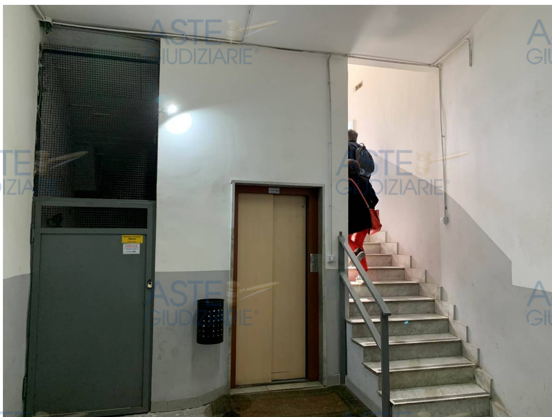
Foto 17 – Scale condominiali verso il piano seminterrato
