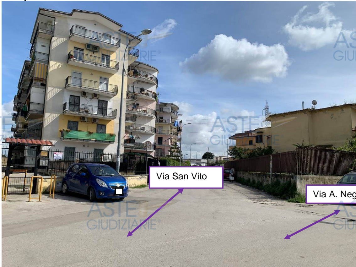
Foto 01 – Il fabbricato dalla via San Vito
