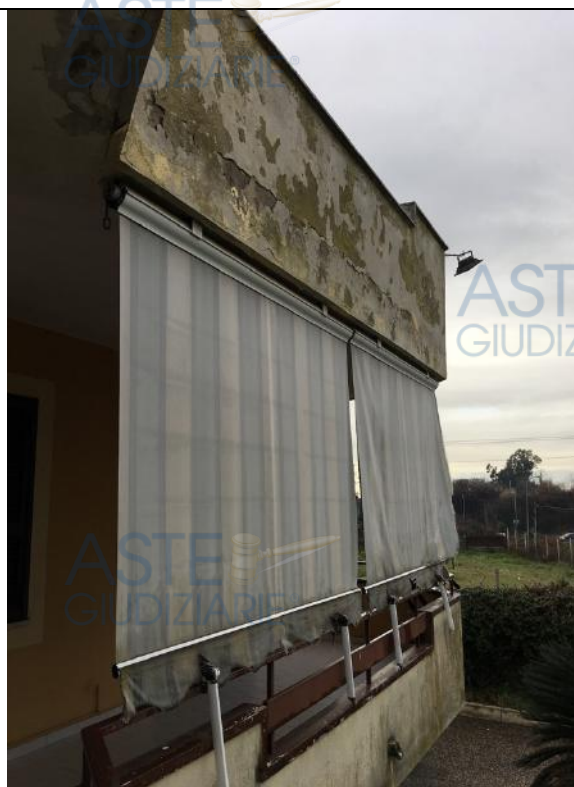
Foto n.2 – particolare tamponatura esterna
