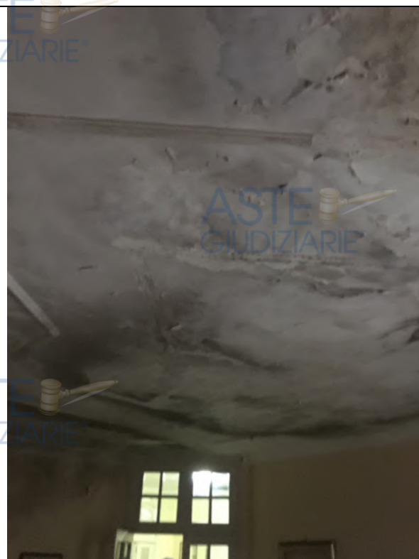
Foto n.1 – particolare soffitto vano piano primo
