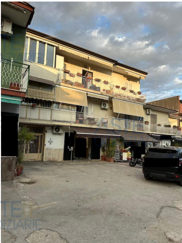
Foto n.1 – Panoramica fabbricato lato strada
