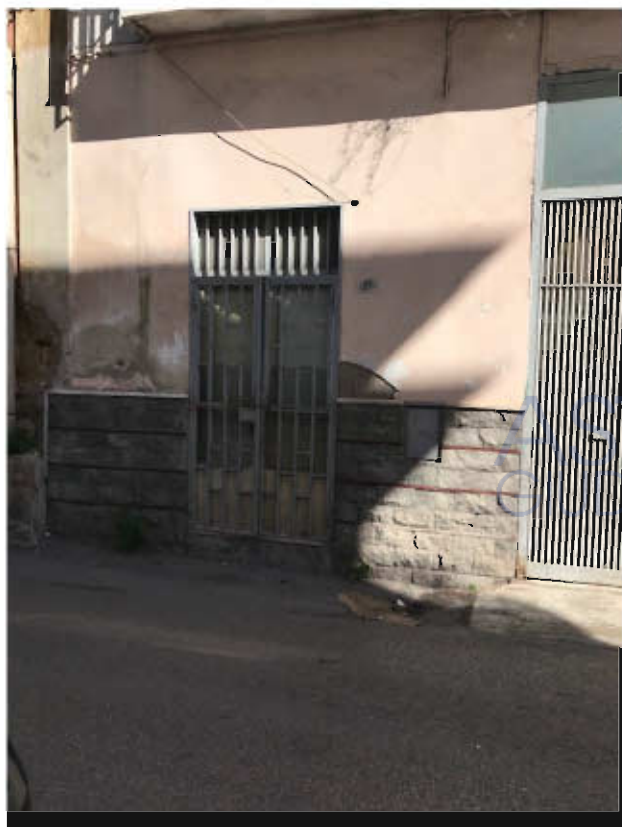
Foto 1. Ingresso locale su Via Ludovico Ariosto interna fabbricato
