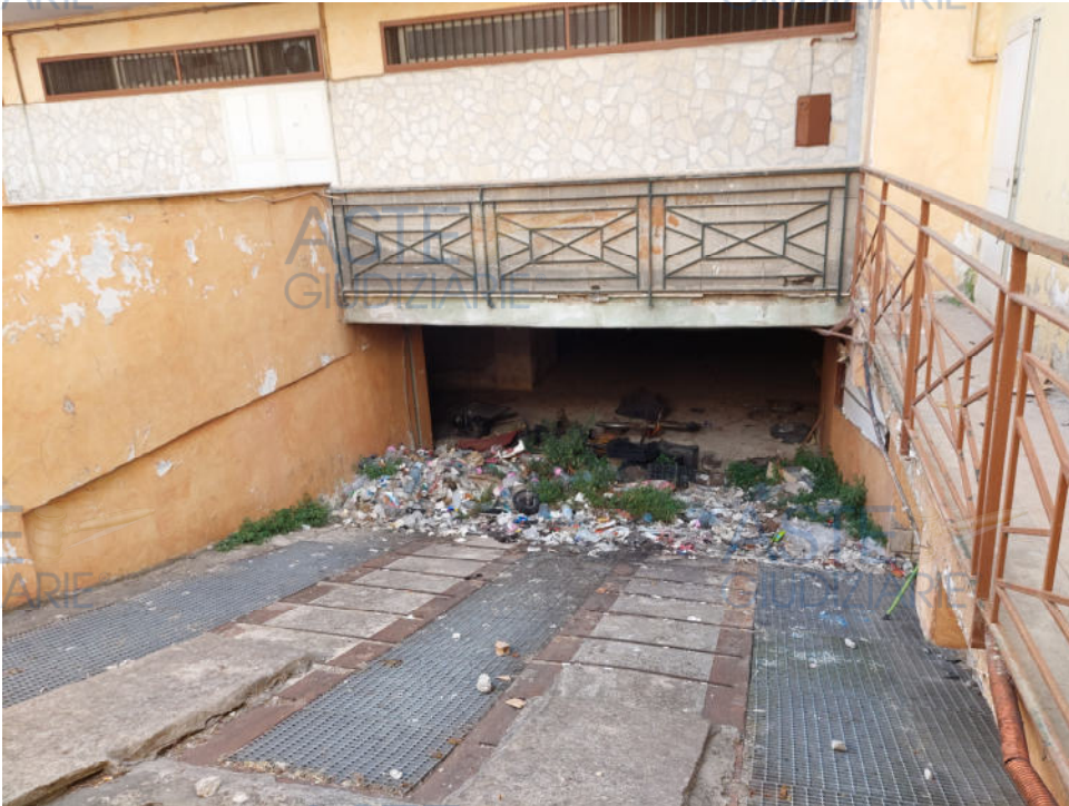
Rampa d'accesso all'area interrata (situazione all'anno 2022)
