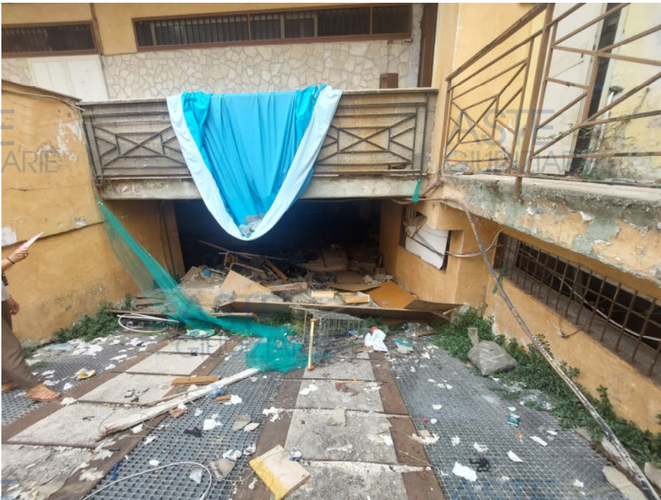
Rampa d'accesso all'area interrata (situazione al 09/09/2025)
