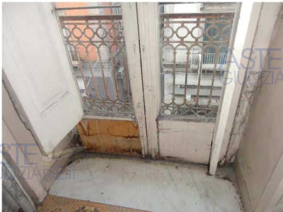
Foto n. 43 – Particolare infisso esterno
