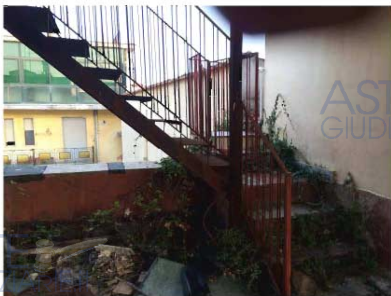
Foto n. 27 – Scala in ferro sul terrazzino
