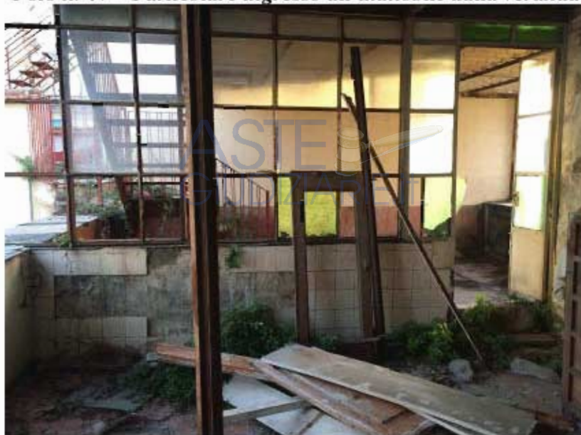
Foto n. 48 – Vista veranda e terrazzino
