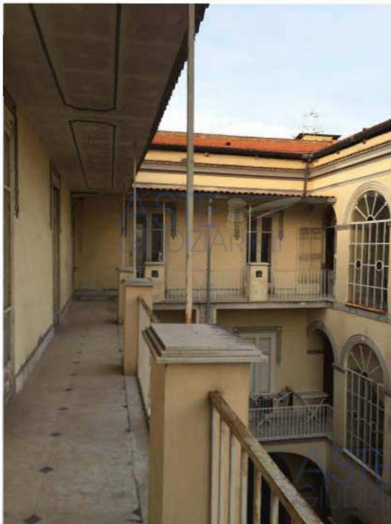
Foto n. . 33 – Vista del ballatoio
