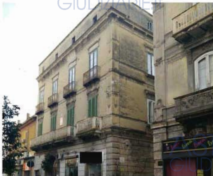
Foto n. 1 – Vista esterna dello stabile
