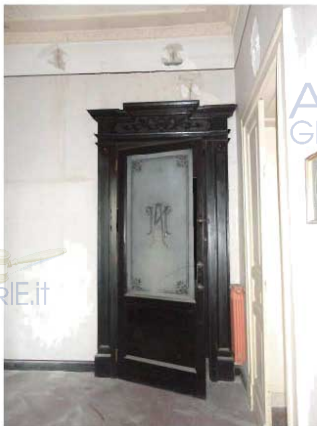
Foto n. 11 – Porta d'ingresso all'immobile
