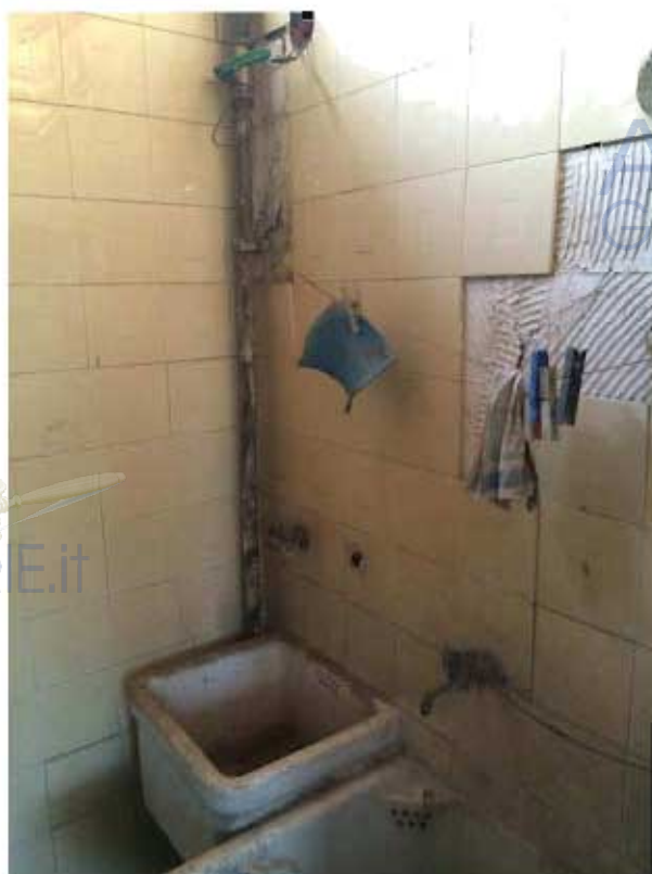
Foto n. 25 – Interno servizio igienico
