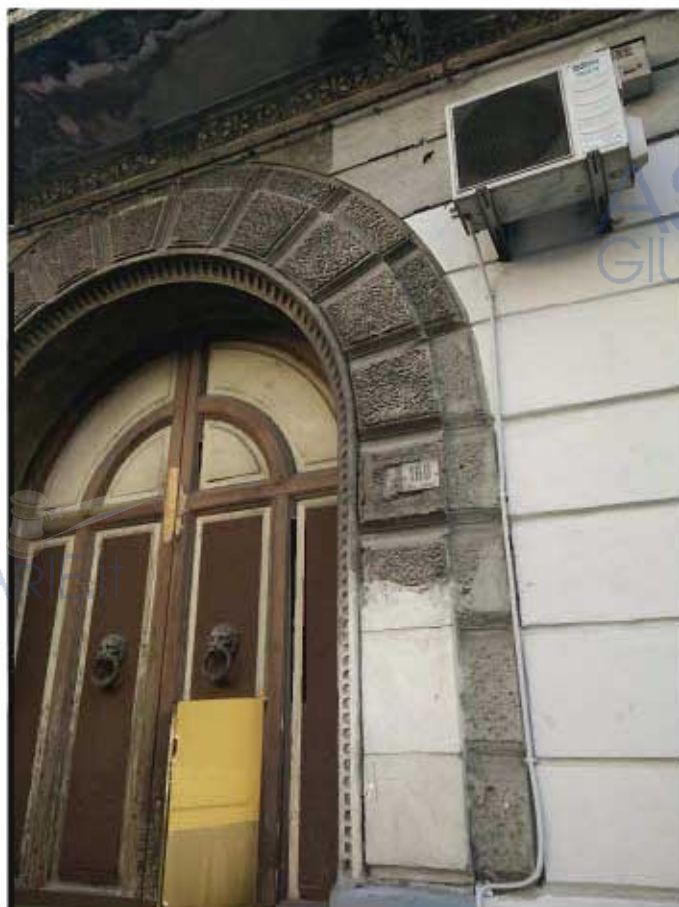
Foto n. 3 – Portone d'ingresso sul Corso Campano
