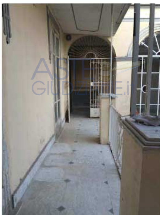
Foto n. 10 – Vista ingresso al ballatoio
