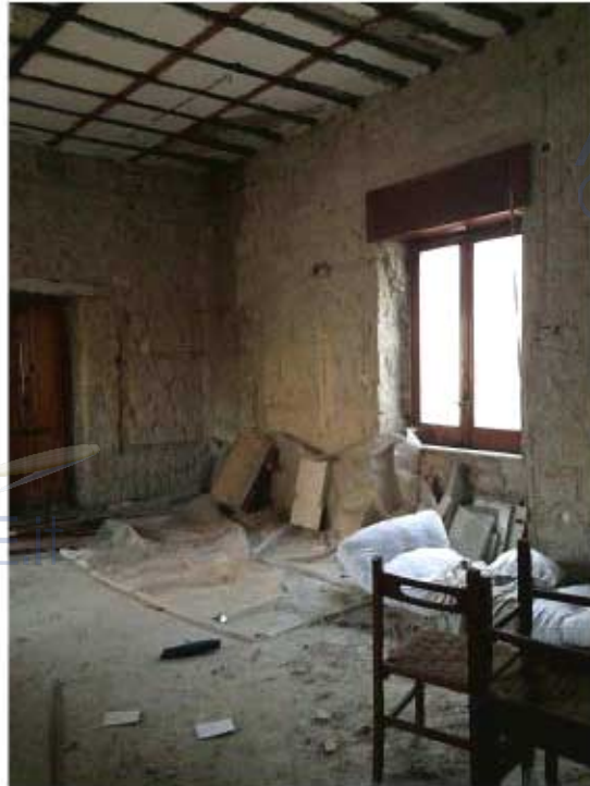
Foto n. 21 – Vista 2) area sottoposta a ristrutturazione
