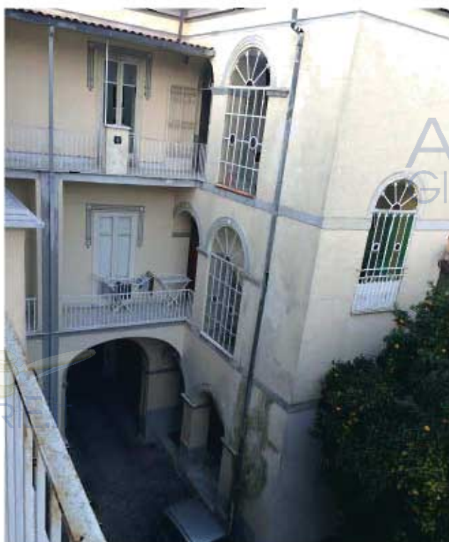
Foto n. 9 – Vista del cortile e del corpo scala
