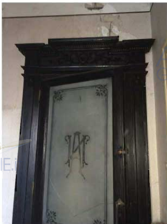
Foto n. 45 – Particolare infisso di accesso all'immobile
