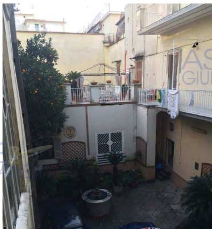
Foto n. 5 – Cortile interno con posti auto
