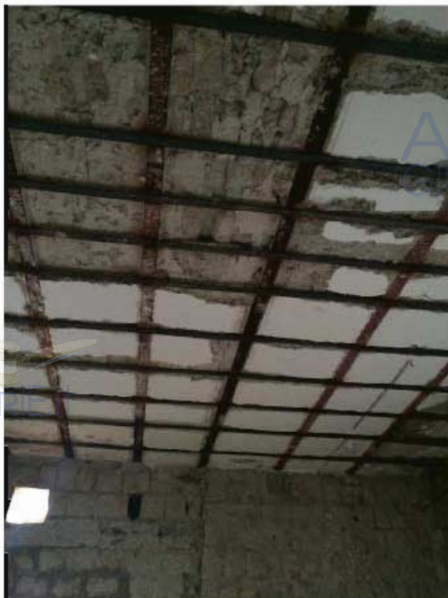
Foto n. 51 – Particolare solaio di copertura interno
