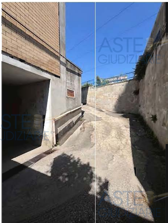
Foto 1. Rampa accesso esterna
