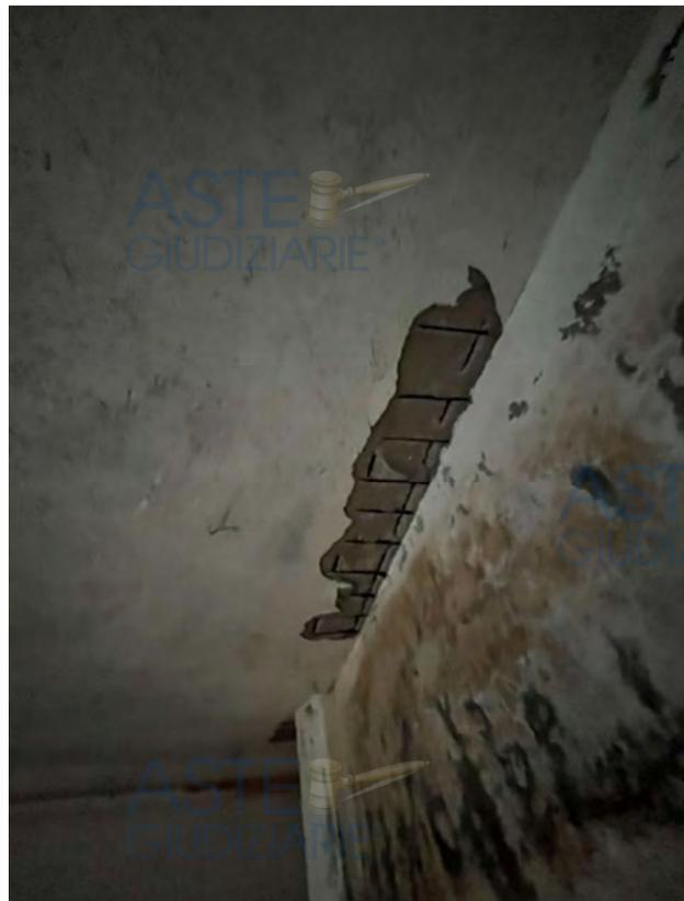
Foto 8. Box interno, particolare solaio con ferri armatura ossidati
