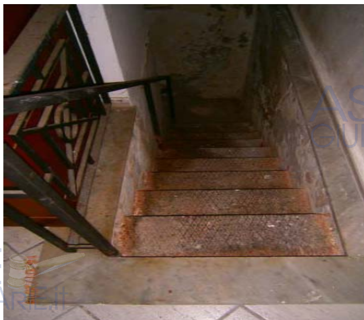
Foto n° 19 Scala Accesso Cantina Immobile P.Ila 99 Sub 1
