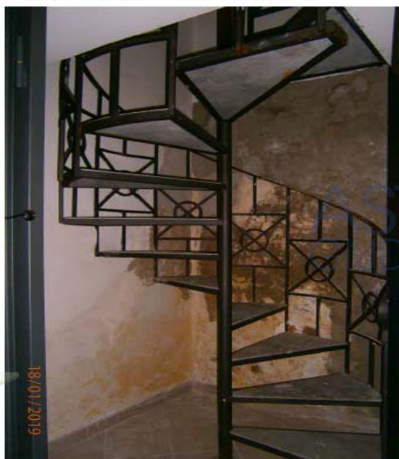
Foto n° 15 Scala Accesso Soppalco Immobile P.Ila 99 Sub 1
