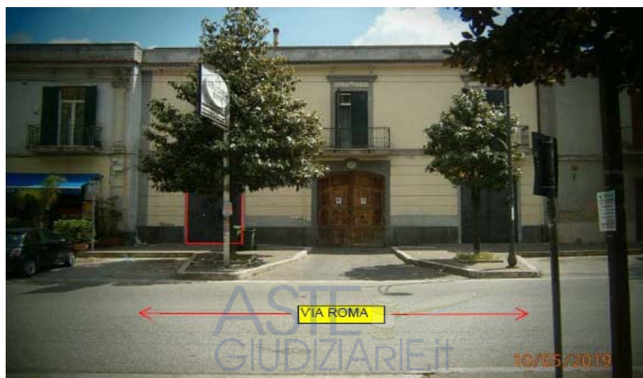
Foto n° 3 Individuazione Bene p.lla 99 sub 1 su Facciata Principale Lato Ovest
