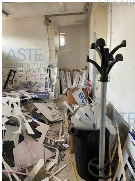
Fotografia n. 8 _ Retrobottega e wc
