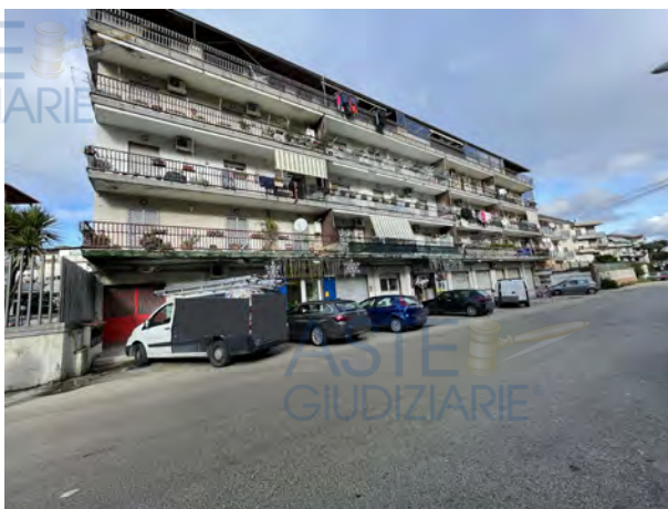
Fotografia n. 1 _ Prospetto su via Fava
