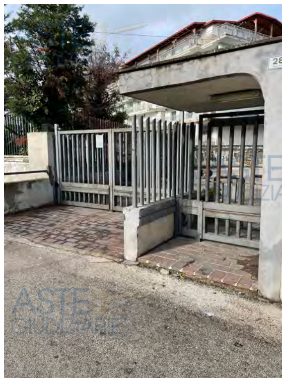
Fotografia n. 4 _ Ingresso all'area comune
