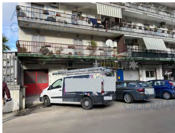
Fotografia n. 2 _ Particolare prospetto su via Fava
