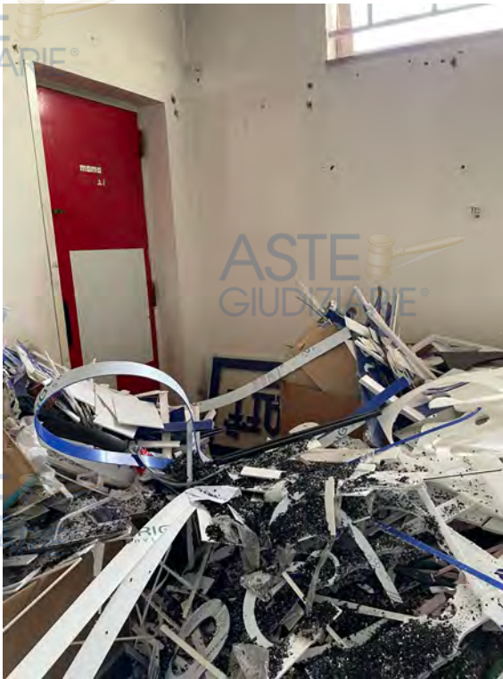
Fotografia n. 9 _ Retrobottega e porta di collegamento al terrazzo
