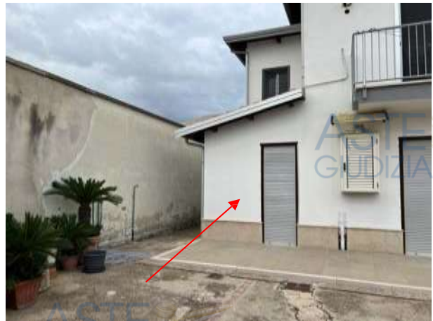
Vista posteriore dell'immobile con evidenza degli accessi all'unità minore del piano terra e dettaglio di uno dei due volumi laterali ottenuto dalla chiusura di un originario portico con copertura a falda di tipo ligneo
