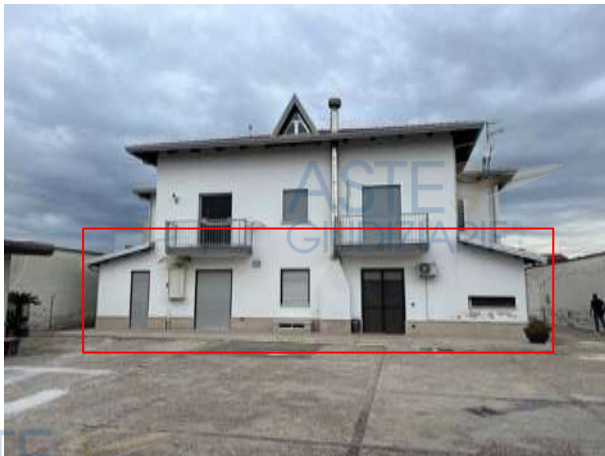
Vista posteriore dell'immobile con evidenza degli accessi all'unità minore del piano terra e dettaglio di uno dei due volumi laterali ottenuto dalla chiusura di un originario portico con copertura a falda di tipo ligneo
