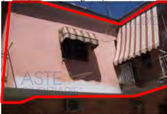
(foto 4: vista prospettica lato corte)
