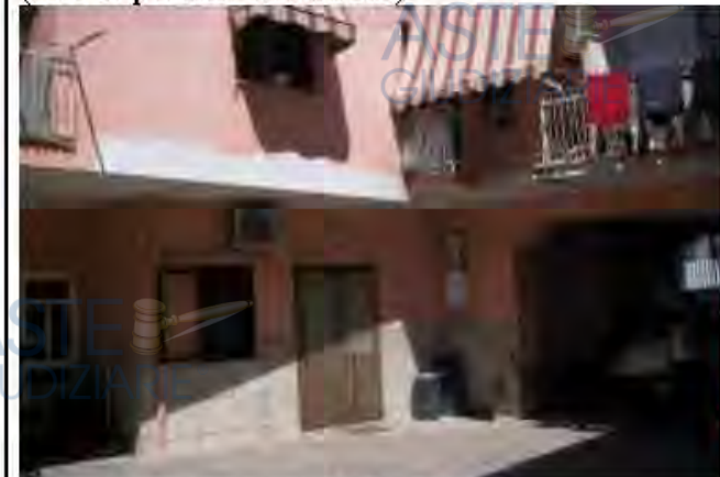
(foto 3: vista prospettica lato corte)
