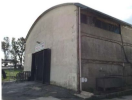
Immobile 05 corpo B esterno
