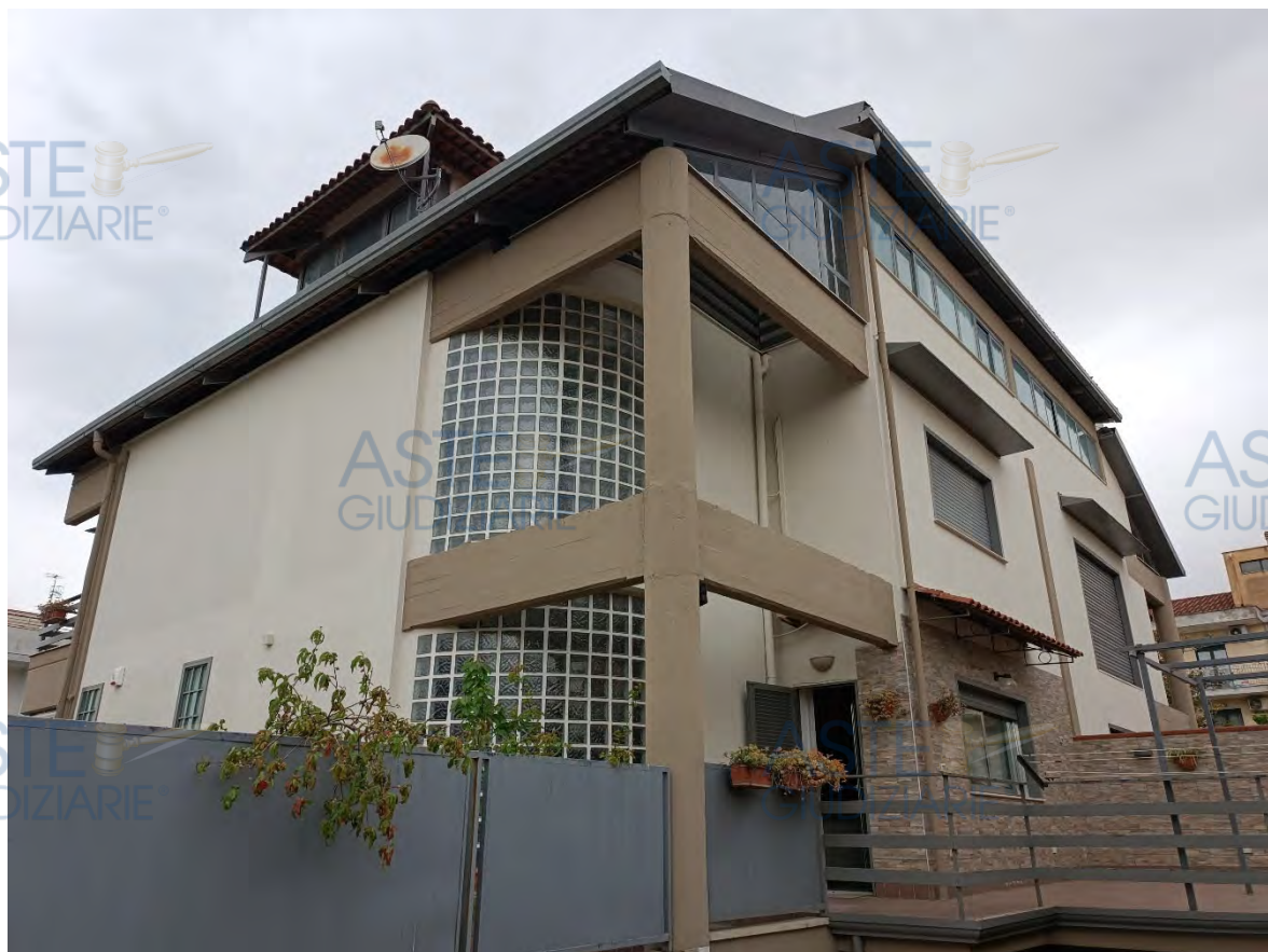
Foto 1. Foto 2. Esterni immobile
