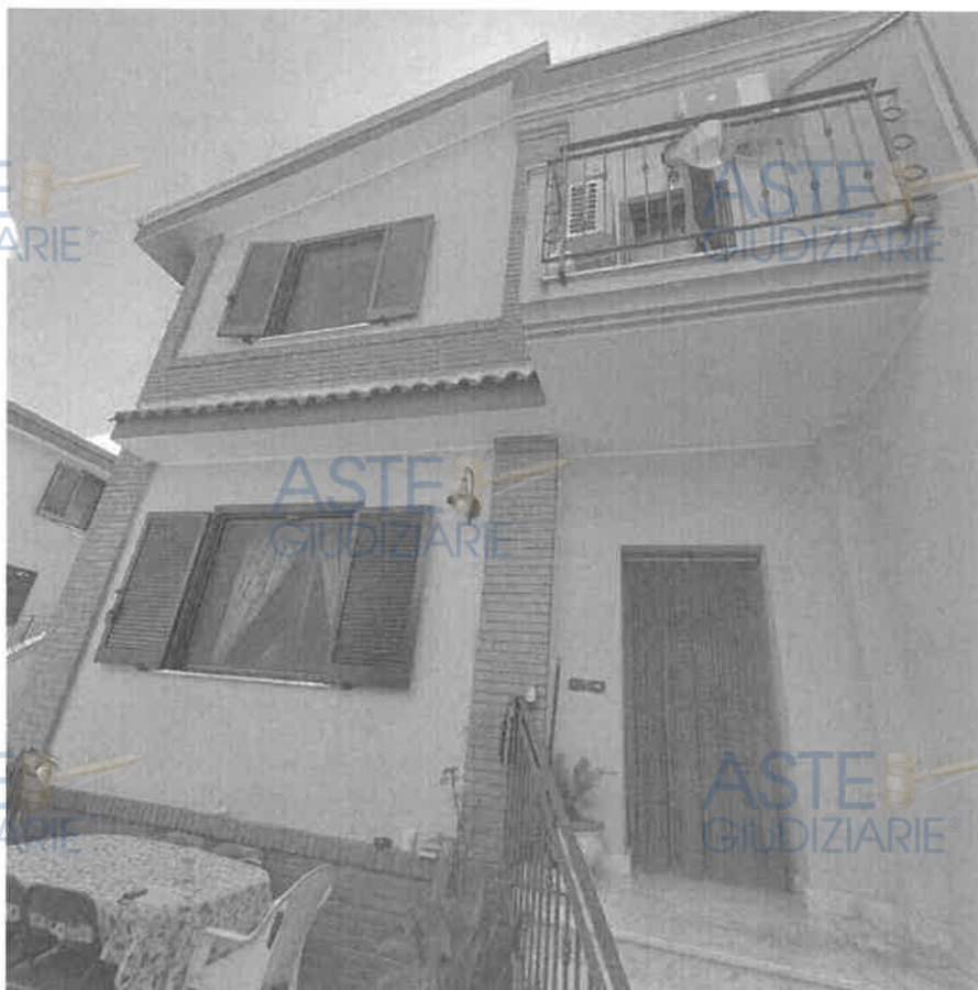
Accesso al piano terra dal cortile
