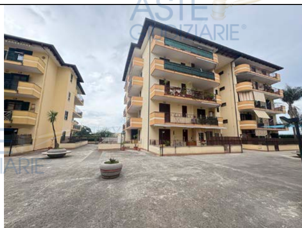
Fotografia n. 3 _ Vista d'insieme del parco residenziale
