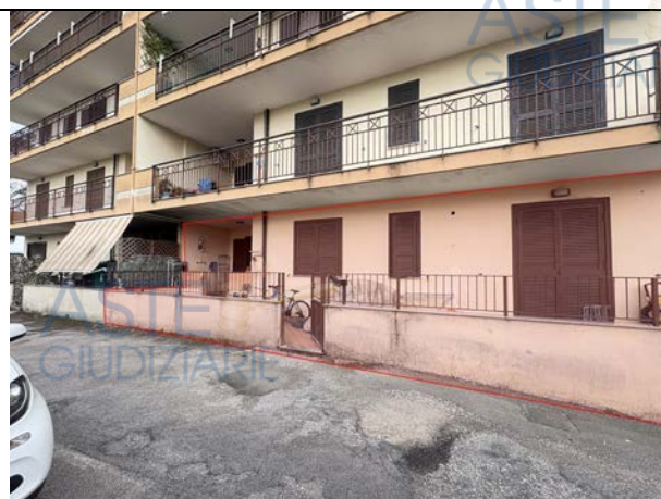
Fotografia n. 4 _ Prospetto ovest con individuazione del LOTTO UNICO
