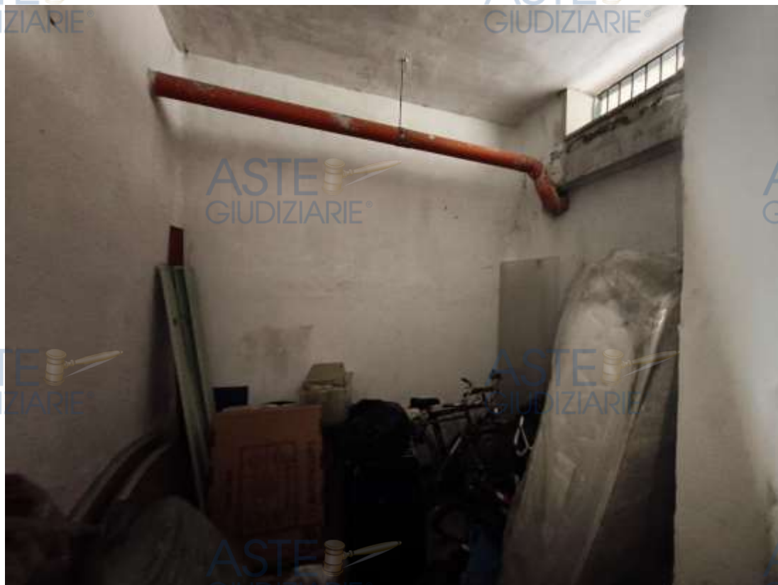
VISTA INTERNA DEL LOCALE DEPOSITO
