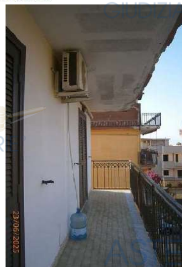
Foto n° 36 Balcone Lato Est
