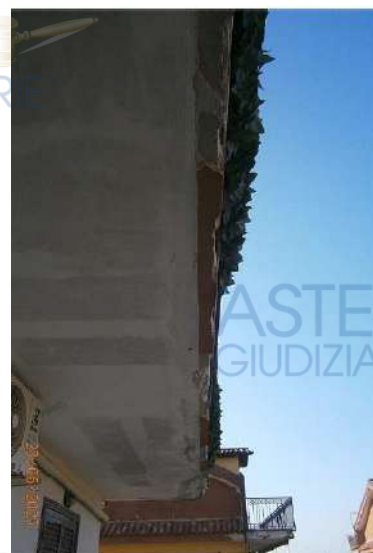
Foto n° 39 Particolare Mensola Lato Est
