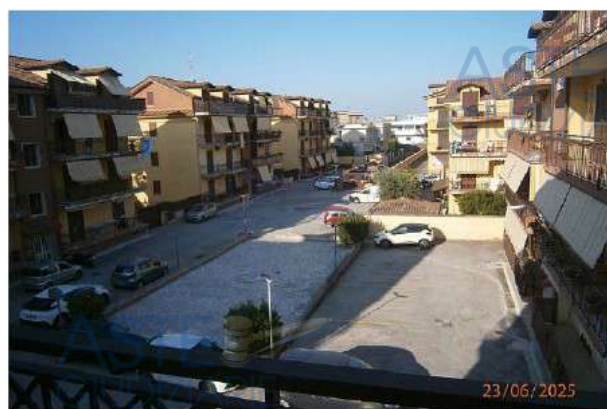
Foto n° 43 Vista Area Condominiale
