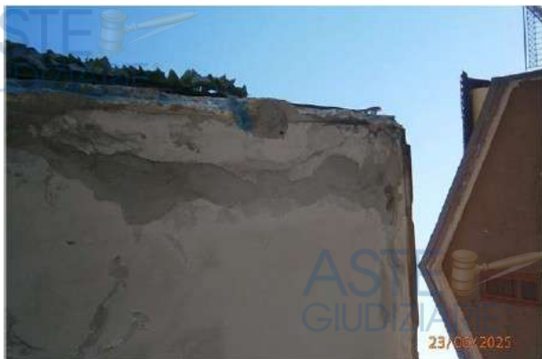
Foto n° 38 Particolare Mensola Lato Est
