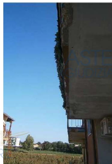
Foto n° 41 Particolare Mensola Lato Est
