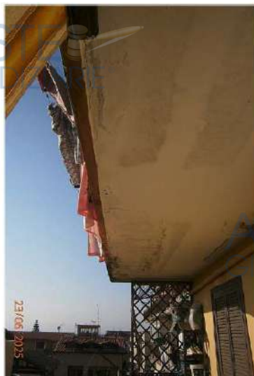
Foto n° 34 Particolare Soffitto Lato Ovest
