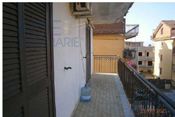
Foto n° 35 Balcone Lato Est
