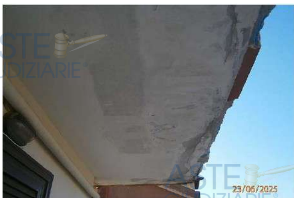
Foto n° 40 Particolare Mensola Lato Est
