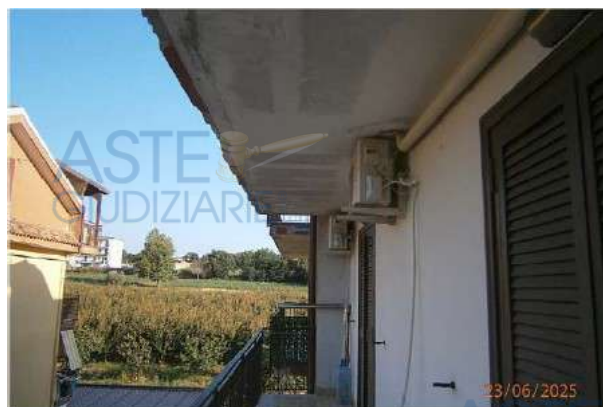
Foto n° 37 Balcone Lato Est
