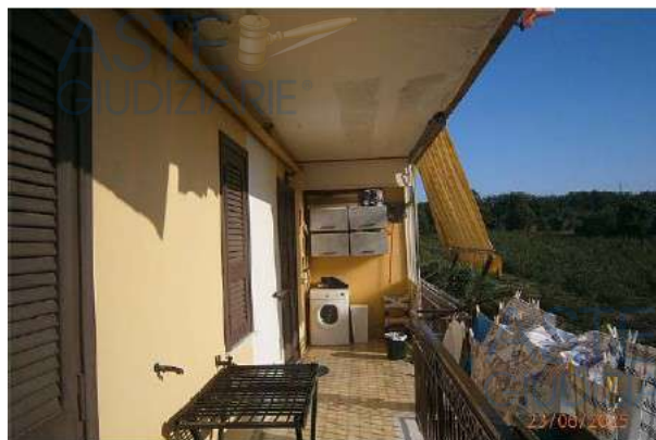
Foto n° 32 Balcone Lato Ovest
