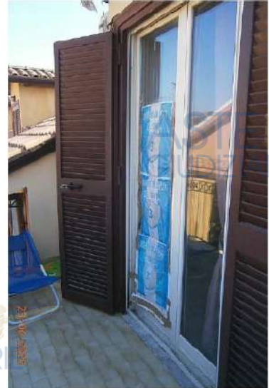
Foto n° 64 Particolare Infisso Esterno
