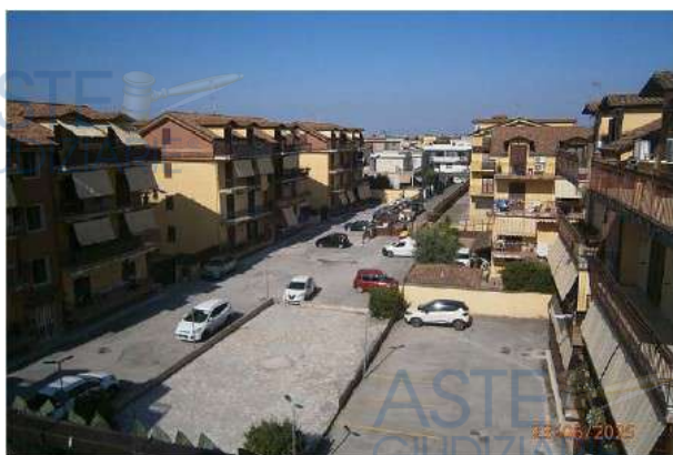
Foto n° 73 Vista Area Condominiale
