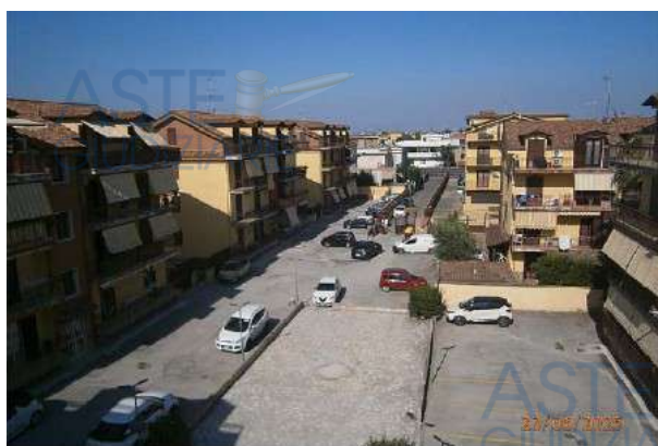
Foto n° 74 Vista Area Condominiale
