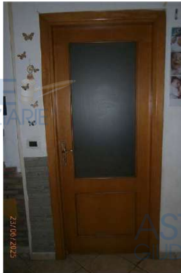
Foto n° 63 Particolare Porta Interna
