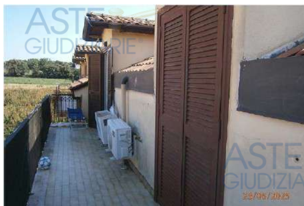
Foto n° 67 Balcone Lato Est
