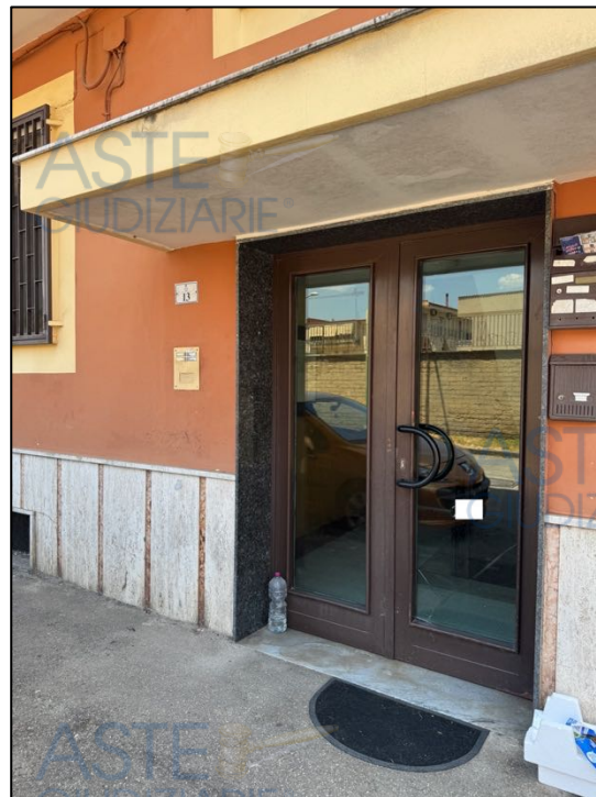
Foto 2 – Accesso androne fabbricato
