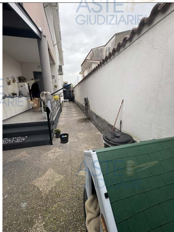
Fotografia n. 3 _ Confine est ed ingresso all'appartamento al piano terra
