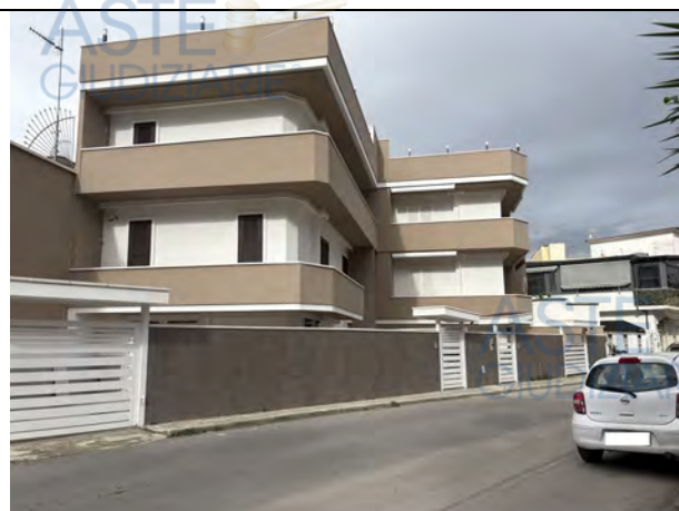
Fotografia n. 2 _ Prospetto su via Napoli, vista sud/nord
