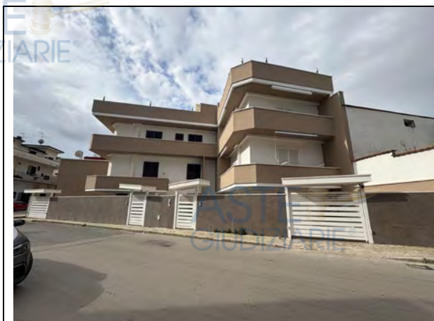
Fotografia n. 1 _ Prospetto su via Napoli, vista nord/sud
