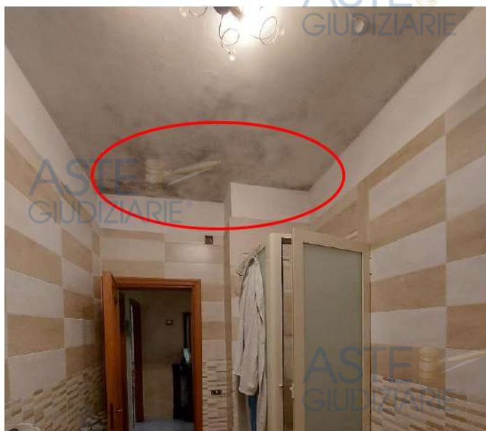
Locale bagno – indicazione presenza fenomeni umidità
