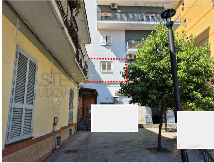
Vista esterna dell'appartamento da Piazza Tammaro Romano
