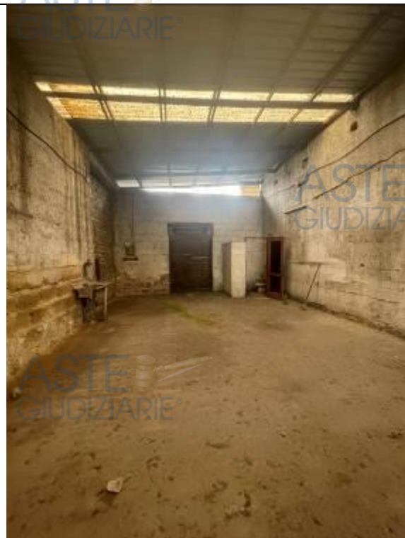
Fotografia n. 8 _ Interno del deposito
