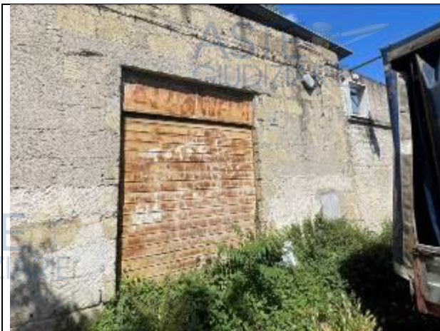
Fotografia n. 1 _ Ingresso al deposito da via Cristoforo Colombo
