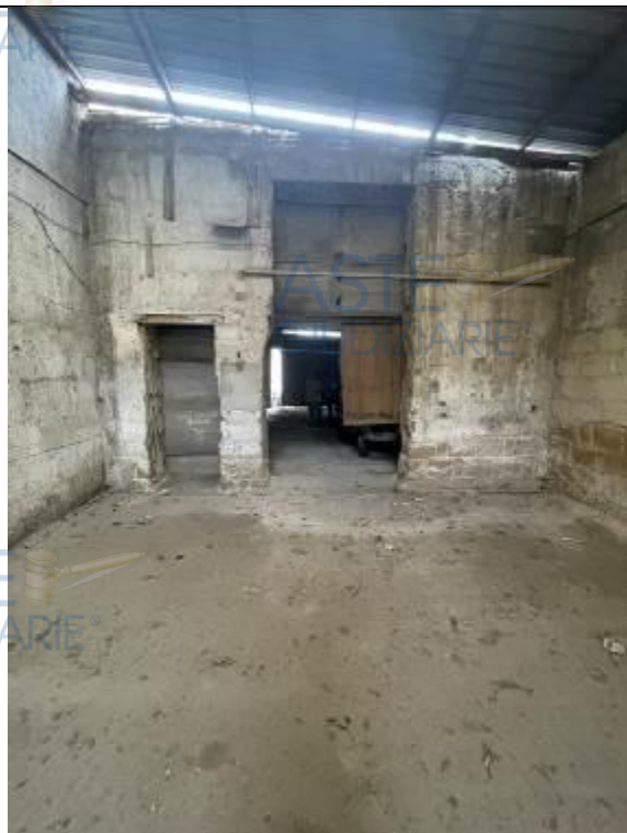
Fotografia n. 7 _ Interno del deposito
