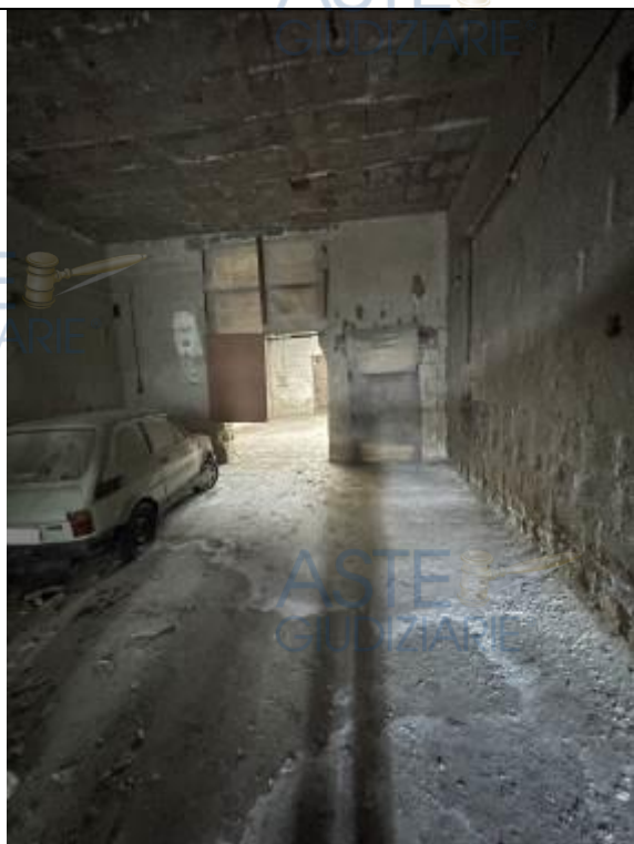
Fotografia n. 9 _ Interno del deposito
