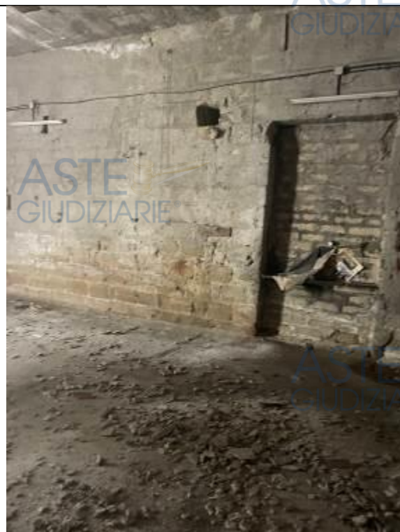
Fotografia n. 10 _ Interno del deposito
