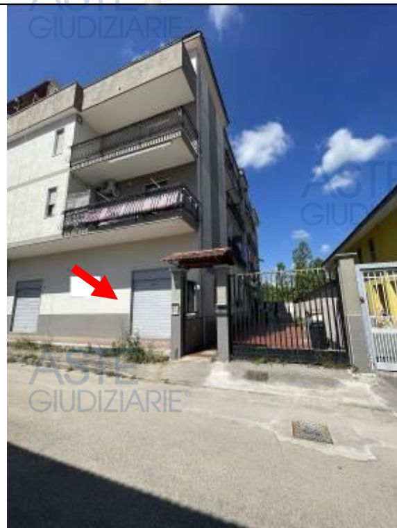
Fotografia n. 2 _ Prospetto su via dei Glicini
