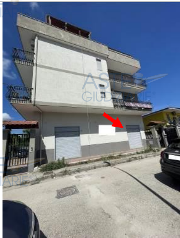
Fotografia n. 1 _ Prospetto su via dei Glicini
