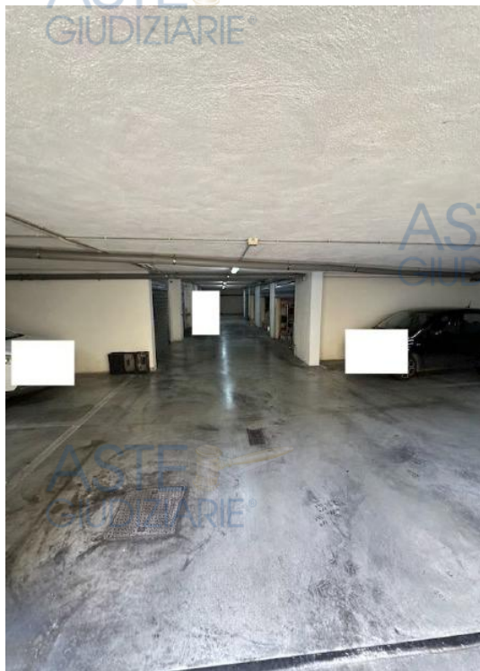
Foto n.5 – Corsia di manovra
