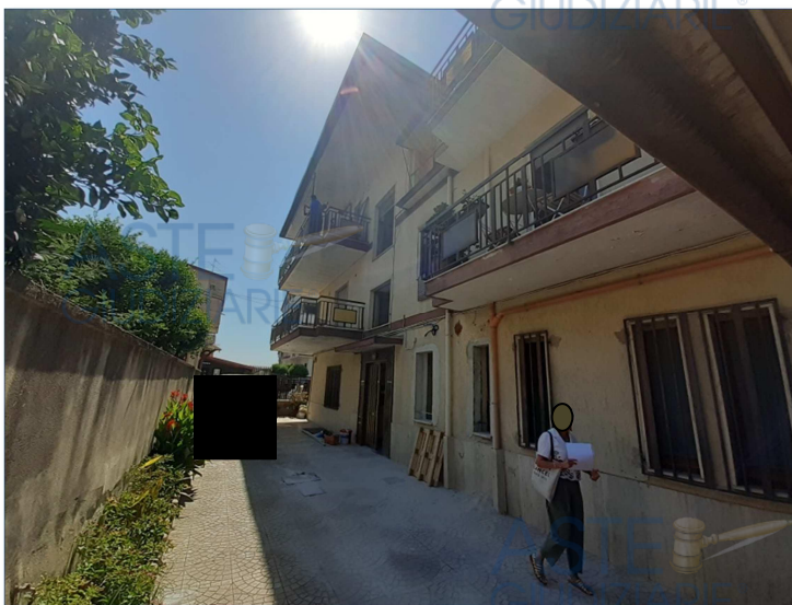
Prospetto Nord fabbricato - cortile condominiale
