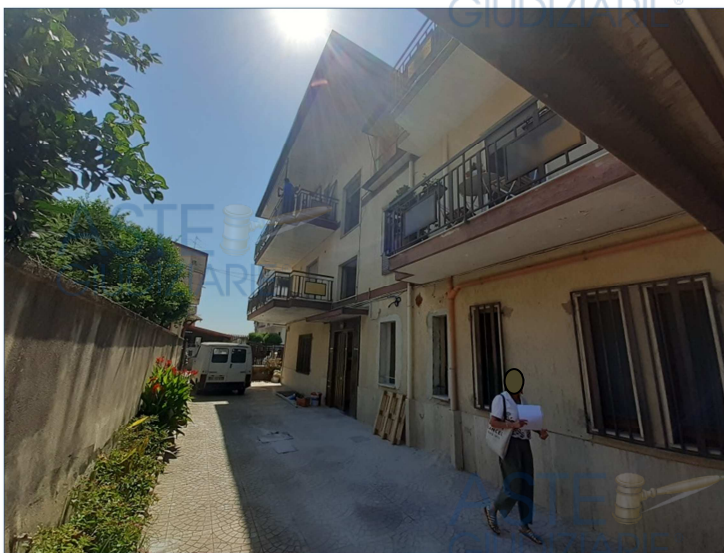
Prospetto Nord fabbricato - cortile condominiale
