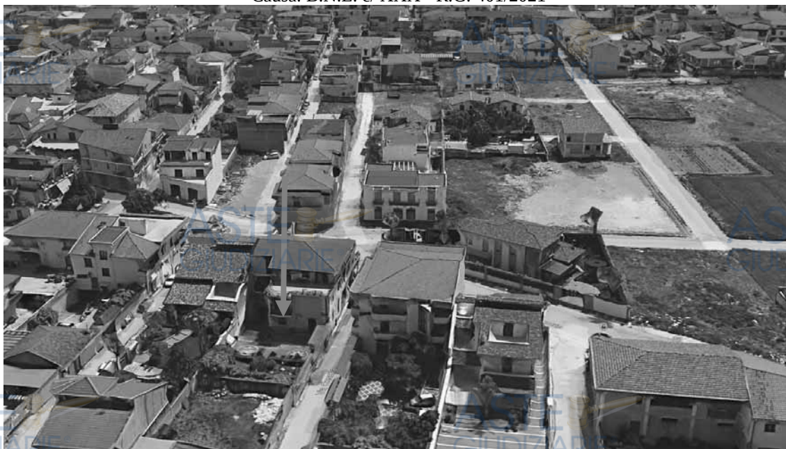
Viste dall'alto del fabbricato
