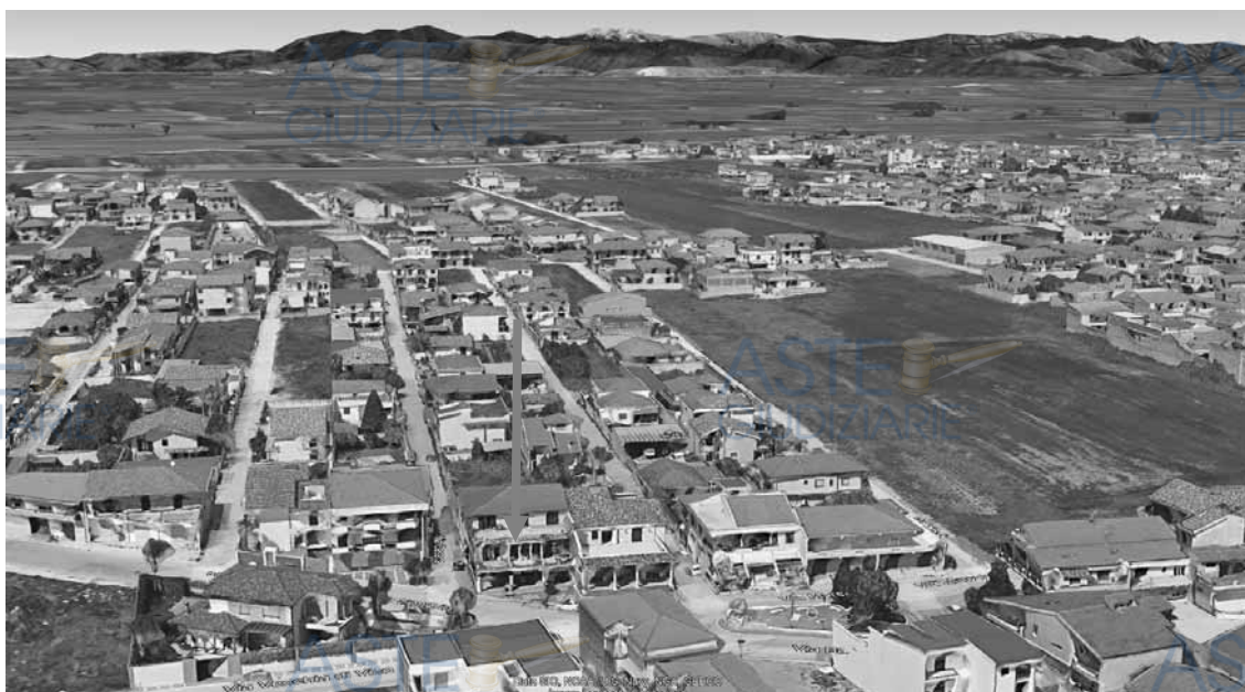
Viste dall'alto del fabbricato
