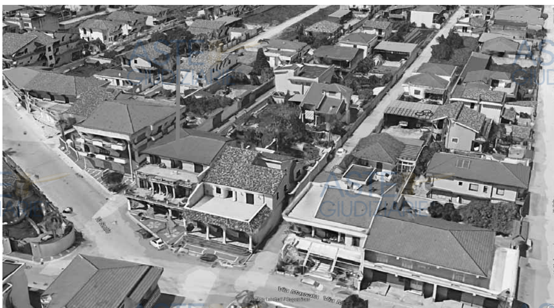
Viste dall'alto del fabbricato
