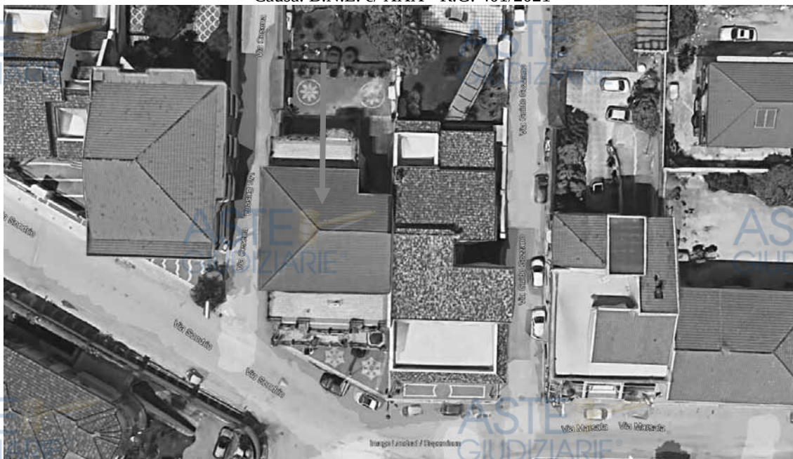
Viste dall'alto del fabbricato
