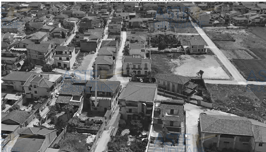
Viste dall'alto del fabbricato
