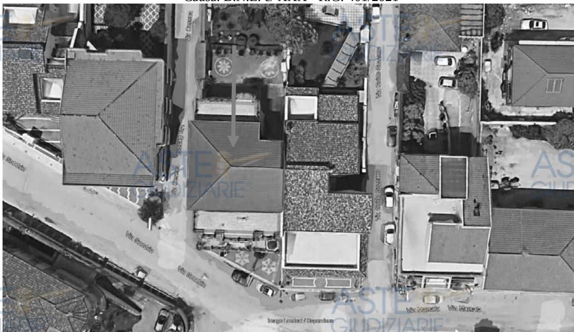
Viste dall'alto del fabbricato
