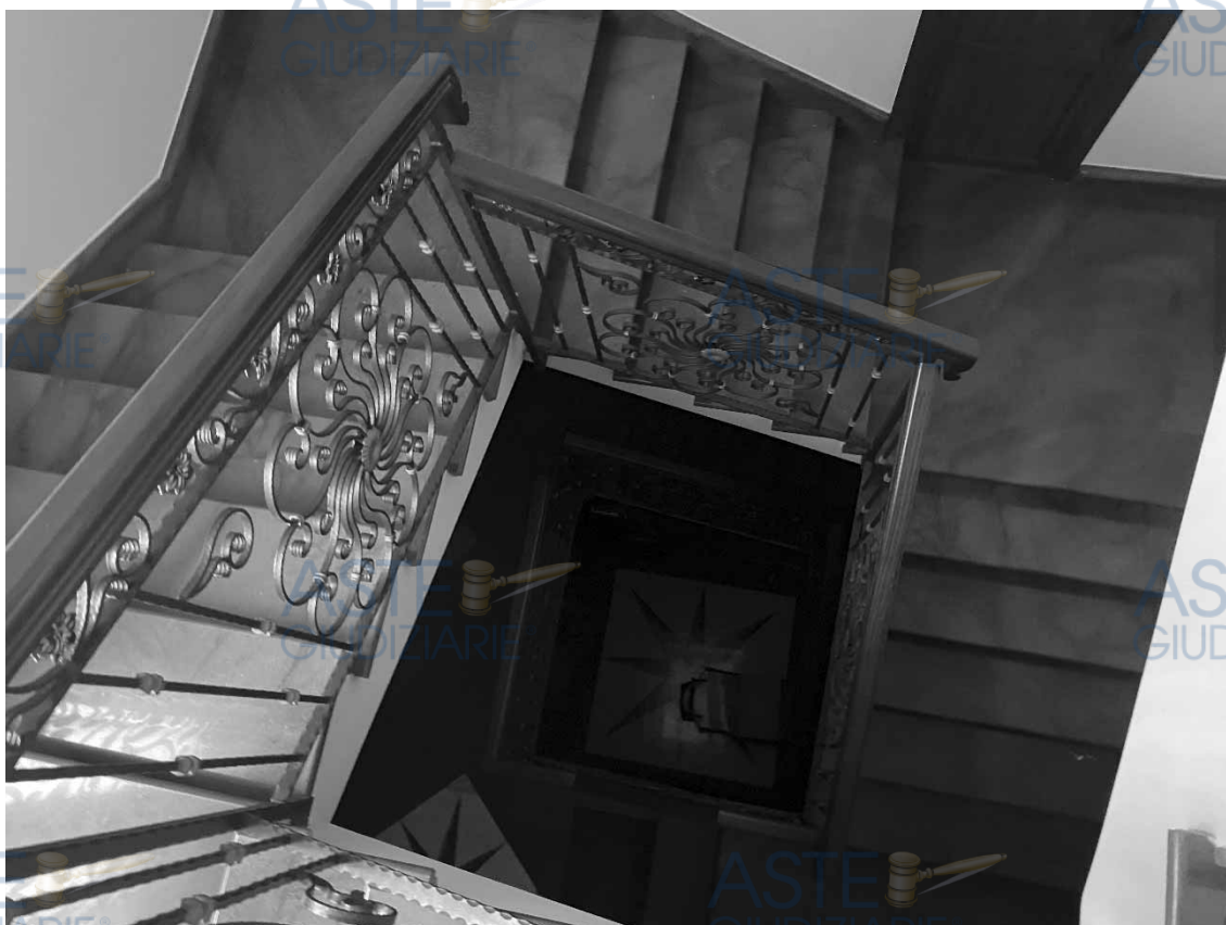
Blocco Scala - sub. 3 -
