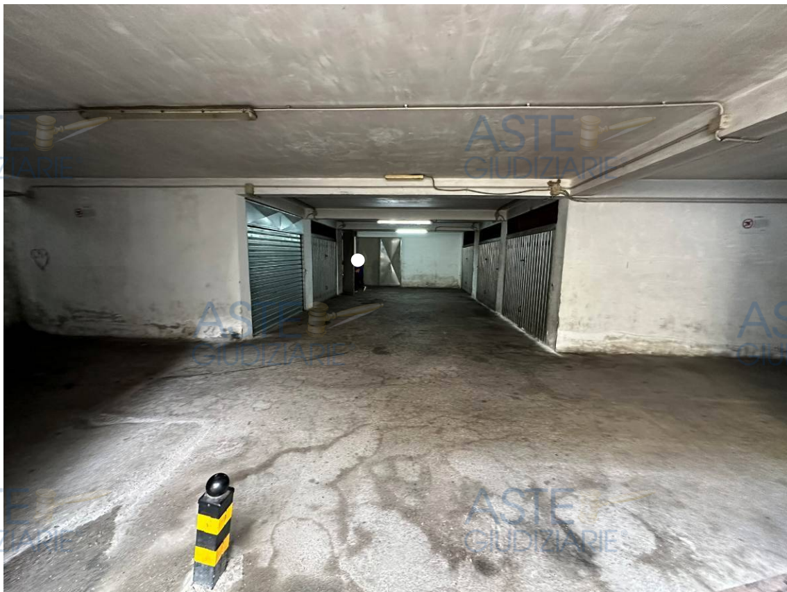
Foto 24 – Area di manovra comune sub 16 bcnc
