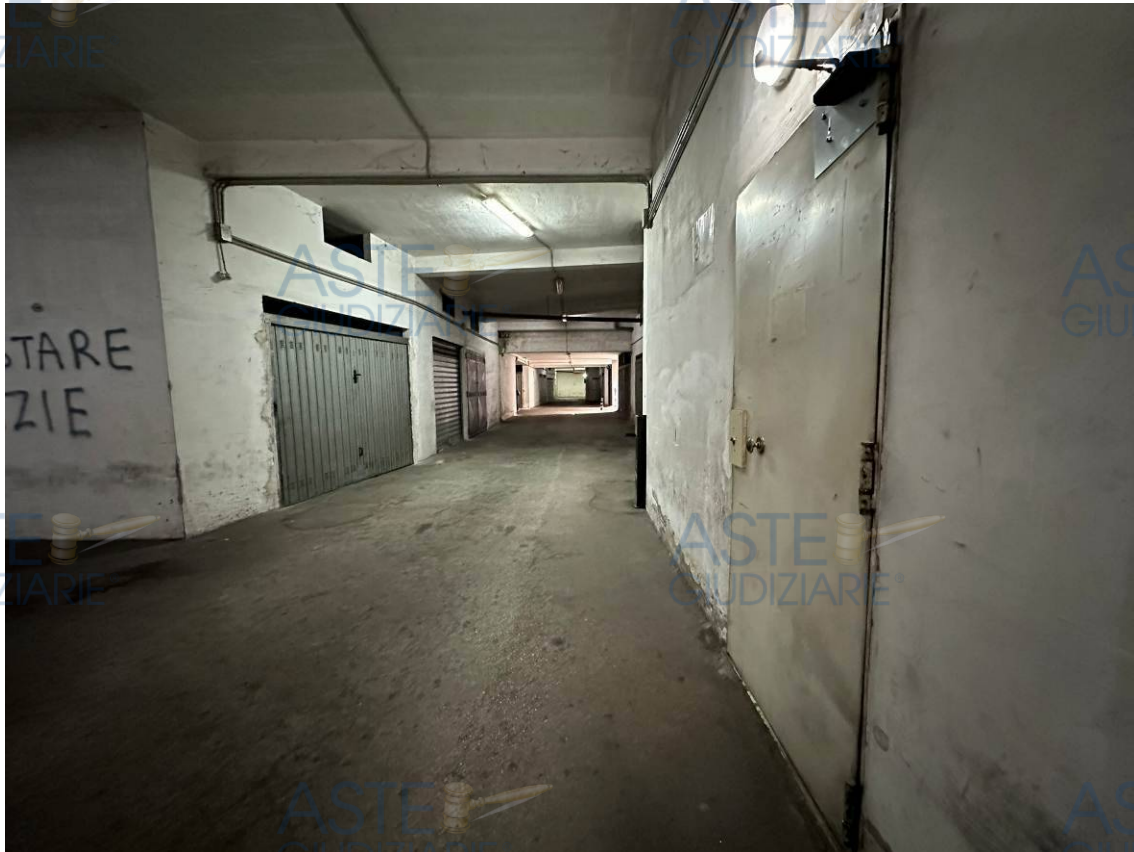
Foto 23 – Area di manovra comune sub 16 bcnc
