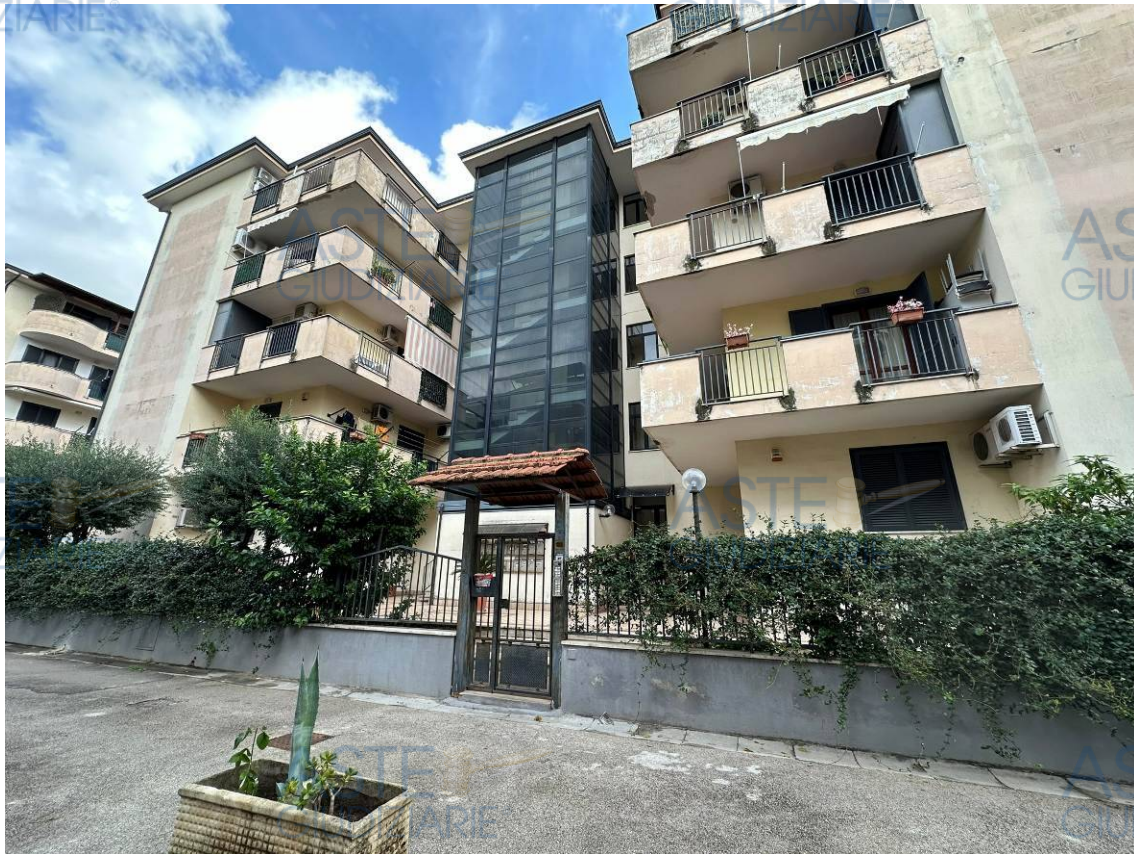
Foto 03 – Il fabbricato B del Parco Anturium dal viale comune sub 1
