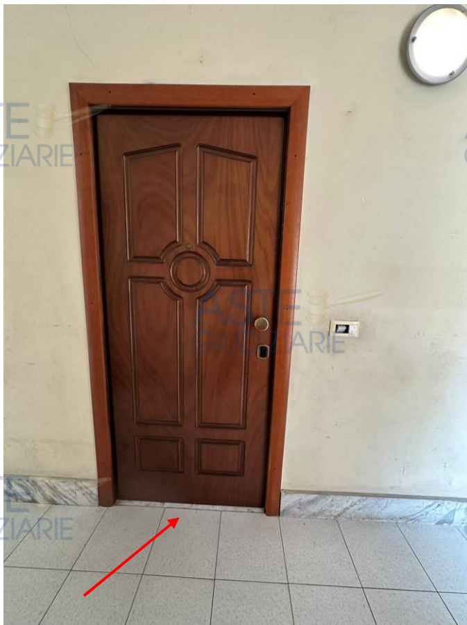
Foto 08 – Il sub 42 dalle scale comuni sub 39 bcnc
