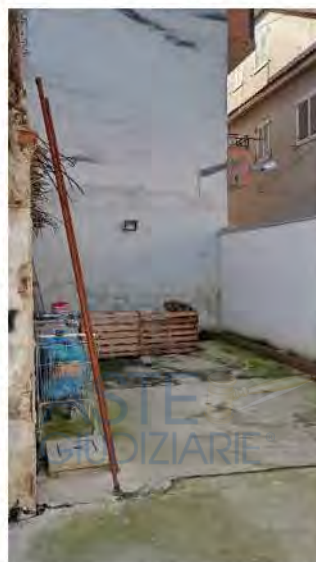
L'area attigua ove insistevano i vani demoliti
