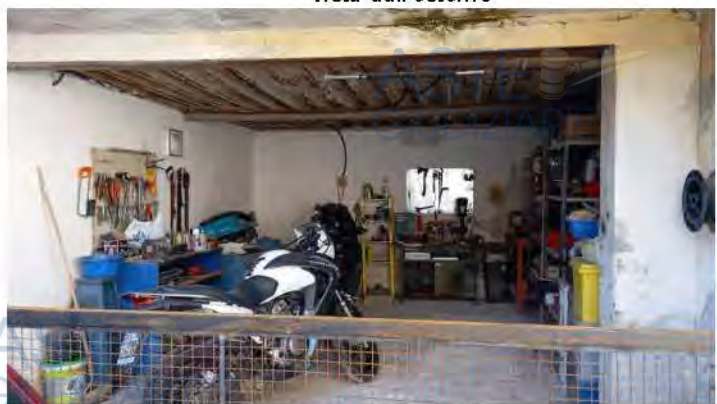
Vista interna del locale autorimessa
