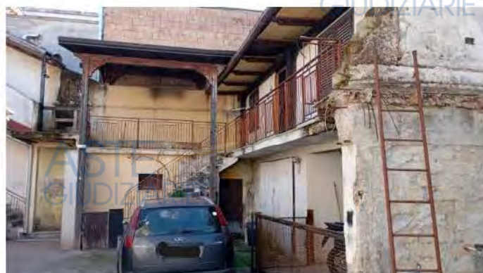
La scala che conduce al bilocale 1° piano
