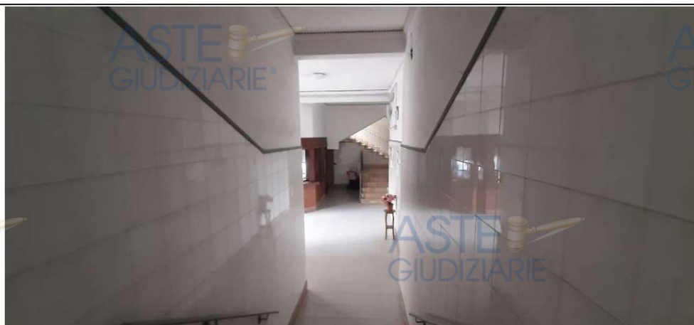
Foto 1/2 - Vista dell'androne e vano scala
