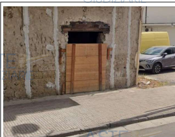
Sub 1 - foto 1 - prospetto dell'unità immobiliare su corso Umberto I
