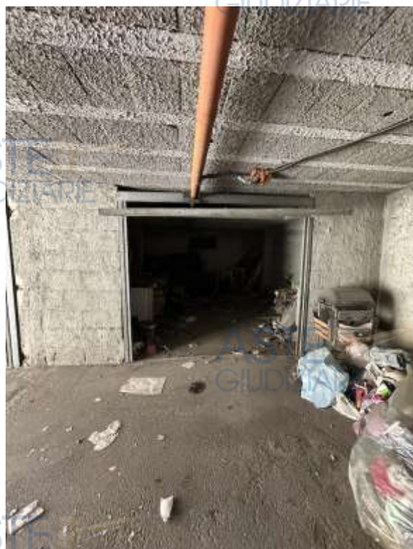
Foto n.6 – Particolare box auto pertinenziale
