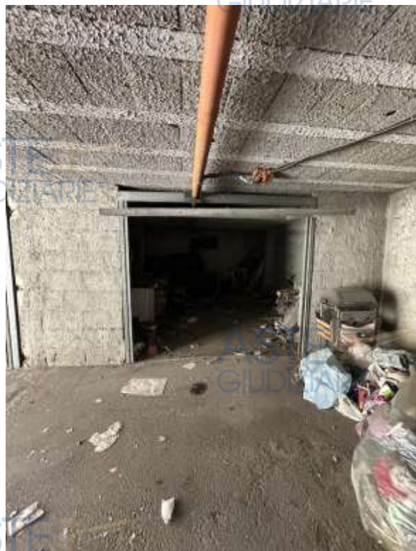
Foto n.6 – Particolare box auto pertinenziale
