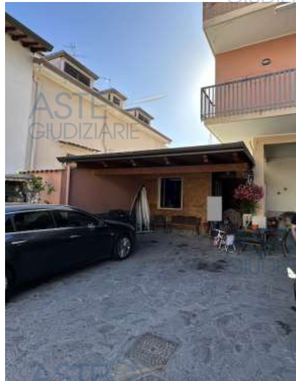
Foto n.3 – Particolare manufatto comune piano terra
